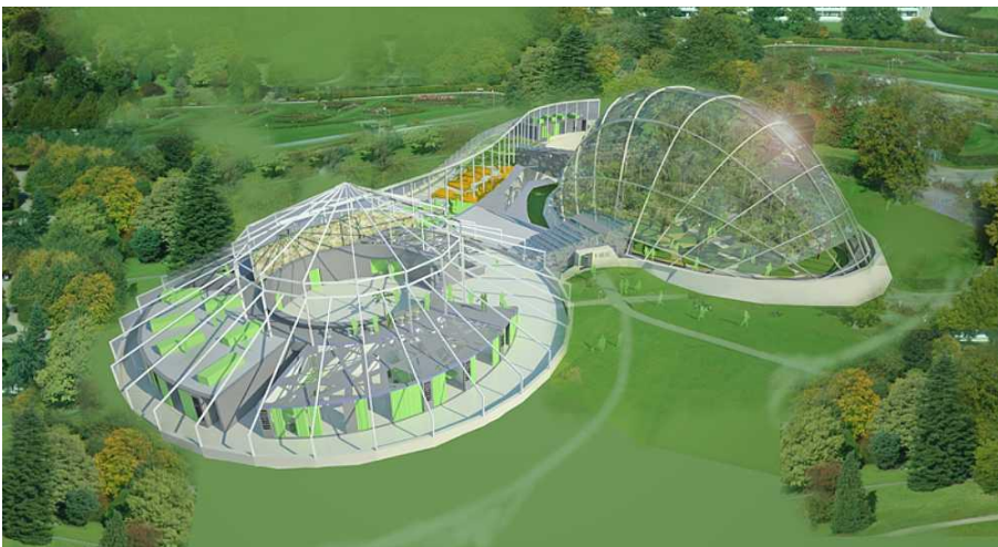
Nytt veksthus i Aarhus – rehabilitering av gammelt glasshus og nytt ETFE-tilbygg. Åpnes vår 2014
