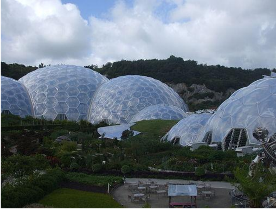
Eden-prosjektet i Cornwall. Bygget rundt år2000
