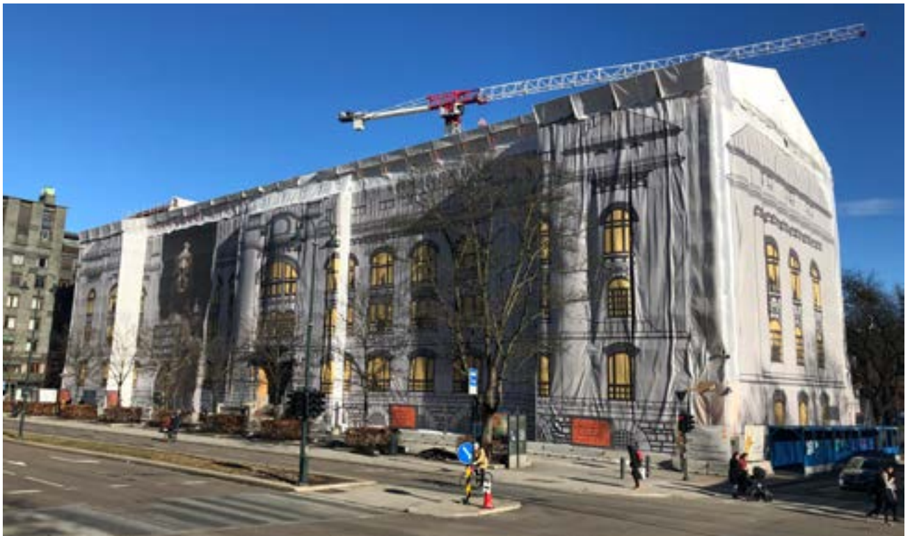
Fasaden på Historisk museum ble rehabilitert 2018-2021. Bygningen må refundenteres.
