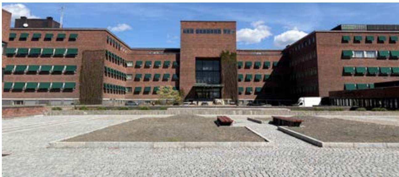
Den brosteinbelagte passen er det rehabiliterte taket på Kjemibygningen. Fysikkbygningen er i bakgrunnen.
