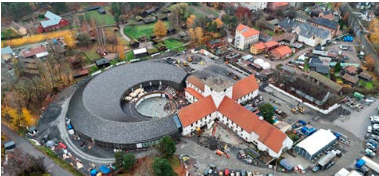
Vikingtidsmuseet vil bli ferdigstilt sommeren 2027. Slik så byggeplassen ut i november 2025.
