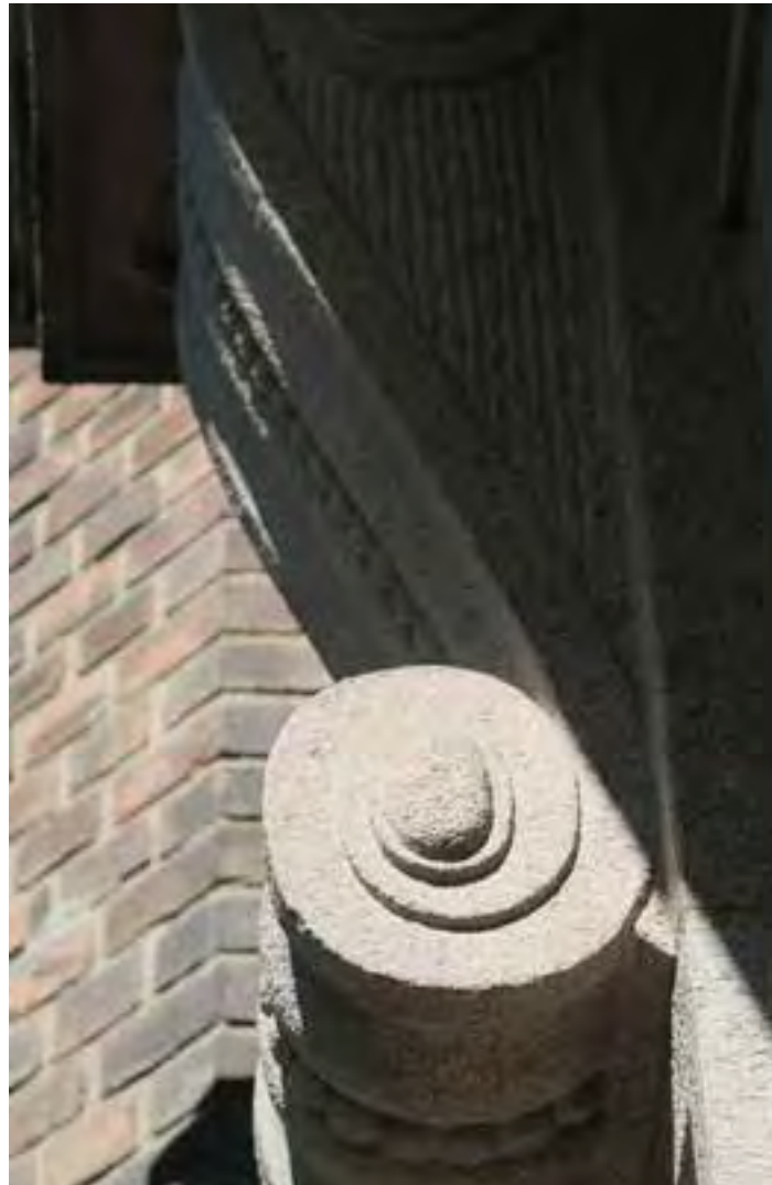
Huggensteinsdetalj ved inngangspartiet
