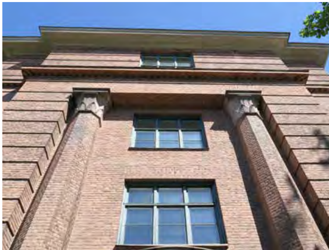
Pilarer og arkitrav over hovedinngangen på sørsiden.
