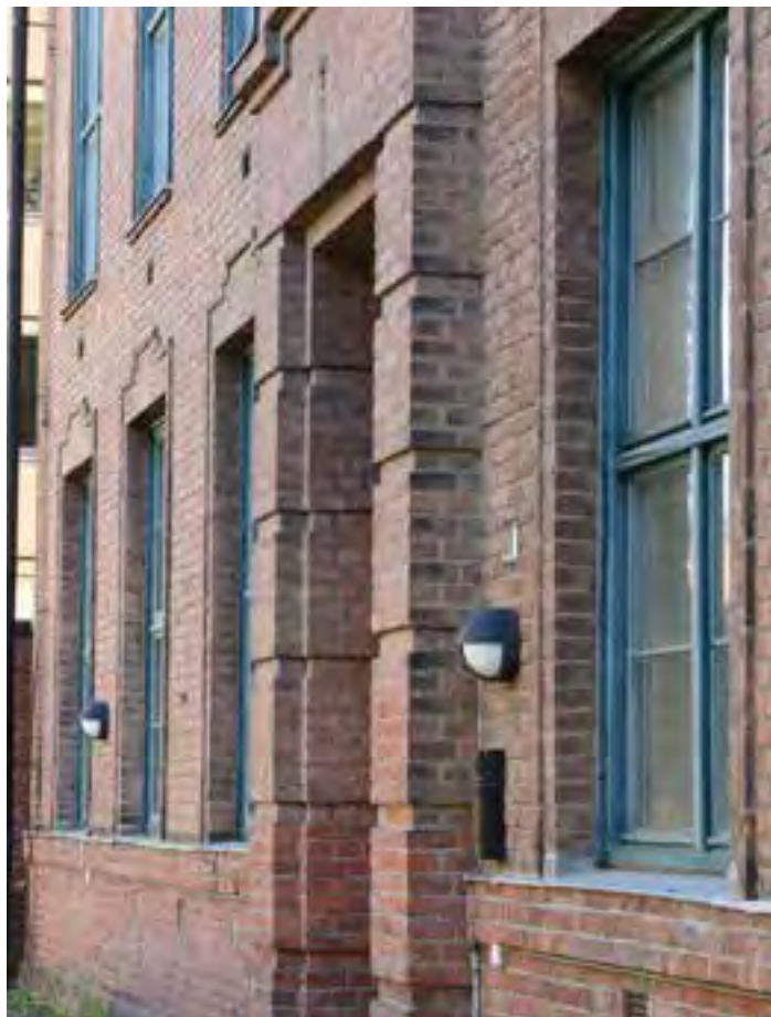
Utsnitt av fasaden ved biinngangen på vestsiden. Lampene er av nyere dato.
