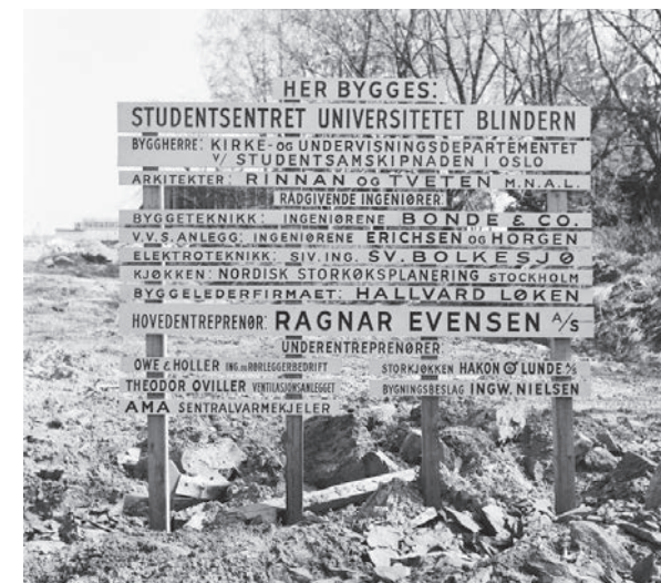
Over: Skilt fra byggeplassen i 1961. Foto: Leif Ørnelund. Eier: Oslo Museum. Under: Frederikke 1961. Foto: Leif Ørnelund
