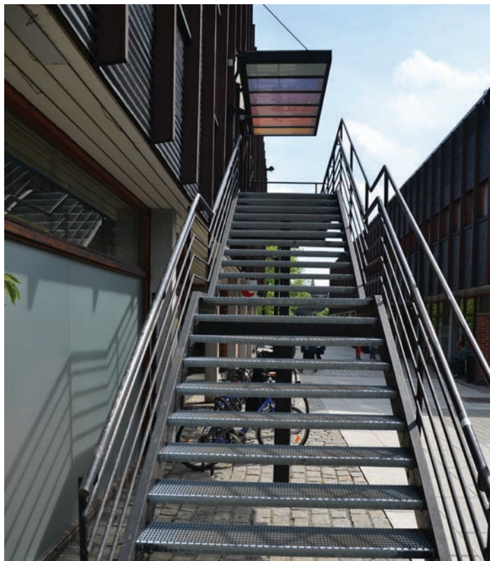
Trappen på fasaden mot sydvest, oppført under ombygginger 1983–1985.
