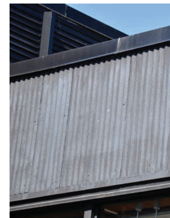
Mindre utskifting av fasadelementer med tilsvarende overflate regnes som vedlikehold. Større utskifting eller endring av fasaden må avklares med Eiendomsavdelingen.
