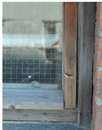
Treverk i vinduer og dører kan vedlikeholdes med tilsvarende overflatebehandling som eksisterende.
