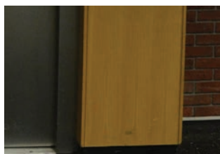
Plater av eikefiner rundt heisen
