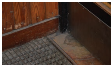
Metallrist og messingbeslag ved dør
