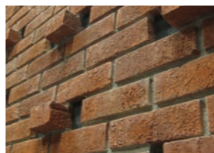
Vegger av tegl
