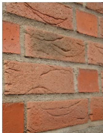
Fuger kan repareres med mørtel som er tilpasset den eksisterende uten at det krever søknad.
