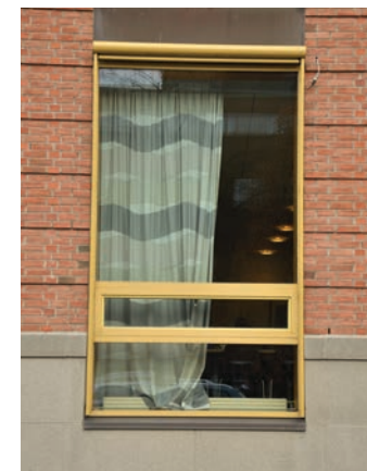
Vinduer og andre malte overflater kan vedlikeholdes med maling i tilsvarende farge og glansgrad uten at det krever søknad.
