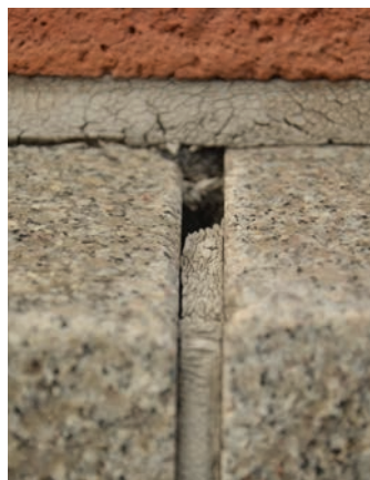
Fuger mellom natursteinen kan repareres ved behov uten at det krever søknad.
