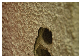
Veggen har to lag maling og sprut-puss.
