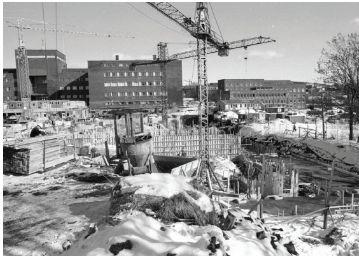
Byggearbeider under oppføringen av Kjemisk institutt. Fysikkbygningen sett fra sør, med Geologibygningen og ZEB-bygningen til høyre, 14.3.1966. Foto: Harald Inge Gjølme/MUV/UiO
