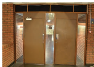
Dører av massivt tre, belagt med linoleum.
