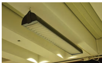
Himling av betong og opprinnelig belysning.
