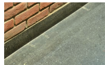
Gulvet er belagt med labradorstein.
