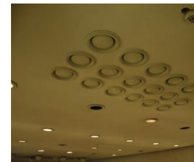
Ventilasjonsluker i himlingen av malt betong.
