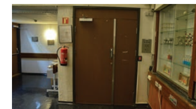
Inngangsdøren ved tavlen er av massivt tre og belagt med linoleum.
