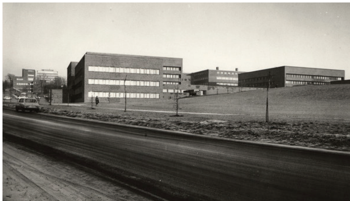
Kjemibygningen og Fysikkbygningen sett fra sørvest. Svein Rosselands hus og Administrasjonsbygningen til venstre, 1970.
