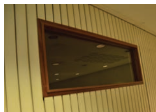
Bakerst i auditoriet er det et teknisk rom.
