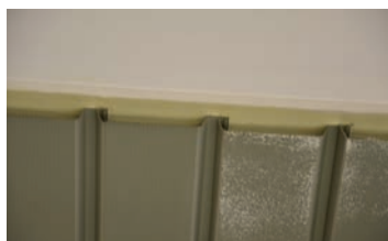
Himling med perforerte aluminiums-plater.
