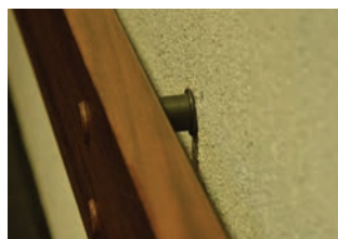
Vegg med sprutpuss og håndløper av lakkert tre, trolig eik eller furu.
