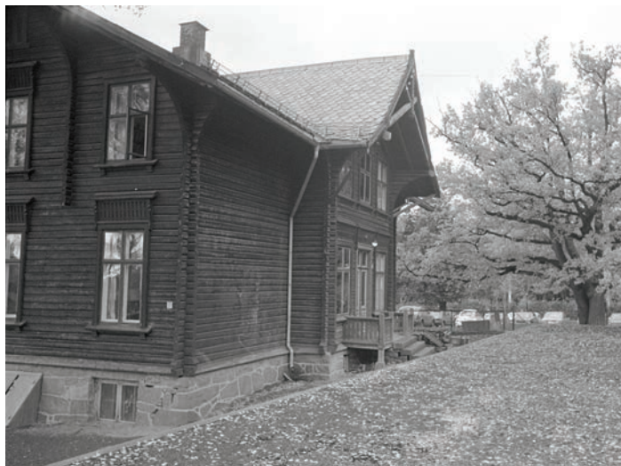
Bygningen sett fra nordøst i 1980. I det nedre venstre hjørnet kan man skimte den opprinnelige kjellernedgangen, som i dag er erstattet av en nyere dør. Foto: MUV, UiO
