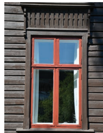
Treverk vedlikeholdes fortrinnsvis med linoljemaling. Malingen bør ha samme farge og glansgrad som eksisterende.
