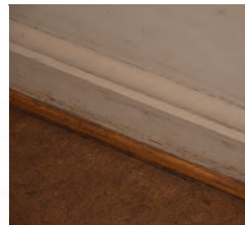
Gulvet er belagt med linoleum. Eldre fotlist av malt tre og smal vaskelist
