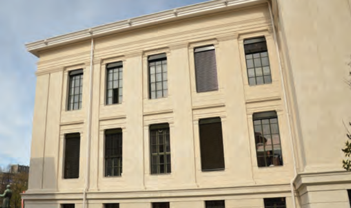
Deler av østfløyens fasade mot sydøst.
