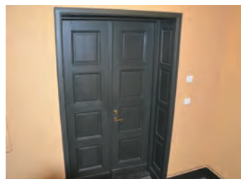
Dør til korridor i mellometasje, 0106
