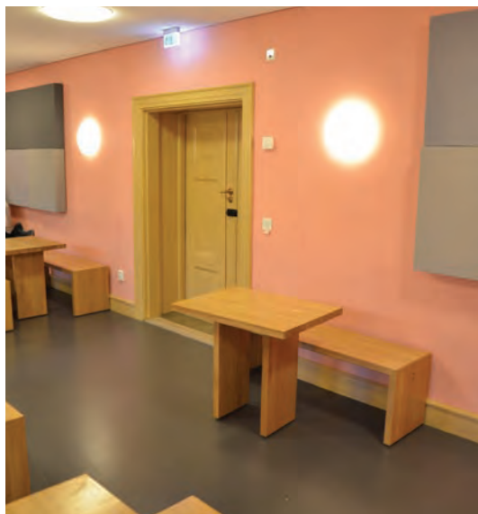
Veggene er pusset og malt, gulvet er belagt med nyere linoleum. Nyere belysning på vegger og i himling.
