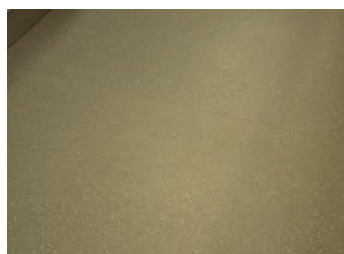
Gulvet er belagt med nyere vinylbelegg.
