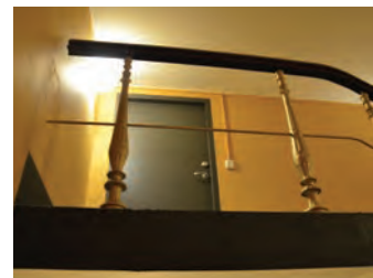
Nyere dør ved det øverste reposit
