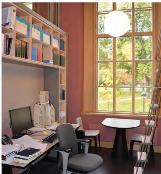
Kontorene har nyere, faste reoler av oljet furu og vegger av glass og MDF.
