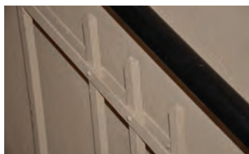
Rekkverk og håndlist av malt stål
