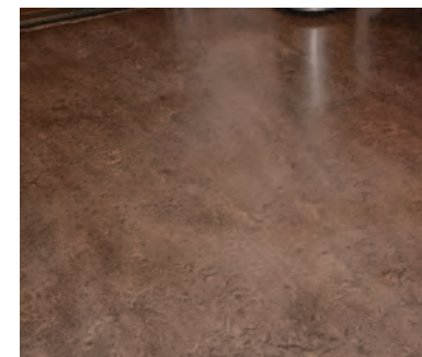
Gulvet er belagt med nyere linoleum.
