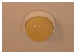
Nyere plafond i himlingen
