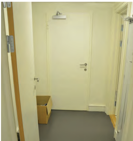
Korridor mellom rommene. Veggene er malt med akrylmaling, og gulvet er belagt med linoleum.
