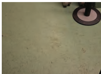
Gulvet i rom 045 av malt betong
