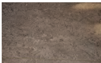
Gulvene er belagt med nyere linoleum.
