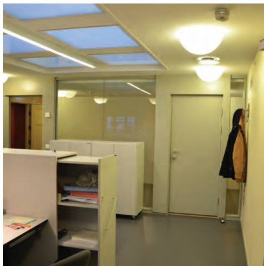
Rommet har nyere innredning og overflater. Ut mot korridor- en er det vegger av glass og MDF. Nyere linoleumsgulv. Him- lingen er kledd med akustikkplater som er pusset og malt.
