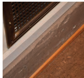
Trolig en eldre fotlist, pusset og malt.
