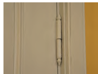
Opprinnelige hengsler på dør til toalettrom
