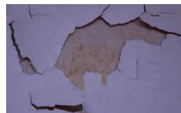
Veggene er pusset og malt, nyere maling flasser av vegg.
