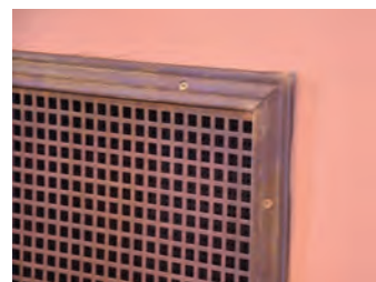
Eldre ventilasjonsrist på veggen
