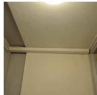
Vegg og himling i vindfanget
