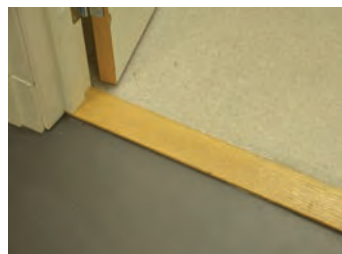
Gulvbelegget i rom 002A er av linoleum og av vinyl i rom 002B.
