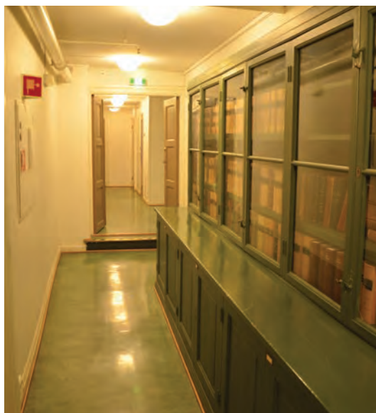
Korridoren har eldre, fastmonterte skap langs veggen.
