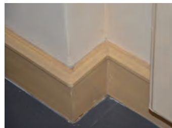
Gulvet er belagt med linoleum. Nyere fotlist
