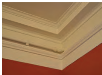
Opprinnelig, profilert taklist
