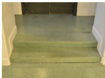
Gulv og trapp er belagt med terrazzo.
