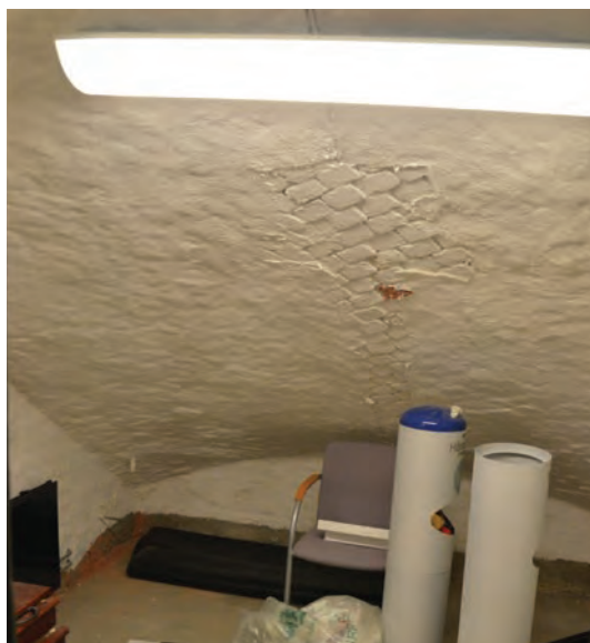
Himling og vegger er pusset og malt.
