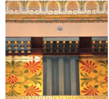
Frise med triglyff, dekorert metope. Dråpeplater/mutuli over
