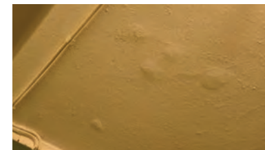
Himlingen er senket og har nyere, malte plater.
