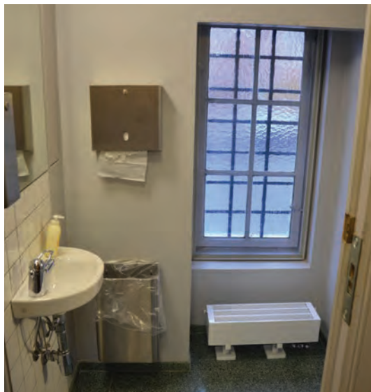
Forrommet har nyere innredning og overflater.
