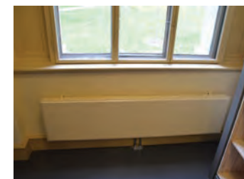
Kontorene har nyere radiatorer.
