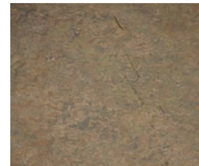
Gulvet er belagt med nyere linoleum.
