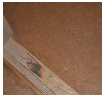
Gulvet er belagt med nyere linoleum.
