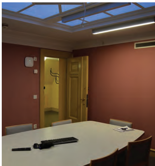
Veggene er pusset og malt. Døren er restaurert og er fra 1830-1840. Nyere belysningsarmatur i himlingen.
