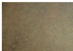
Gulvet er belagt med nyere linoleum.
