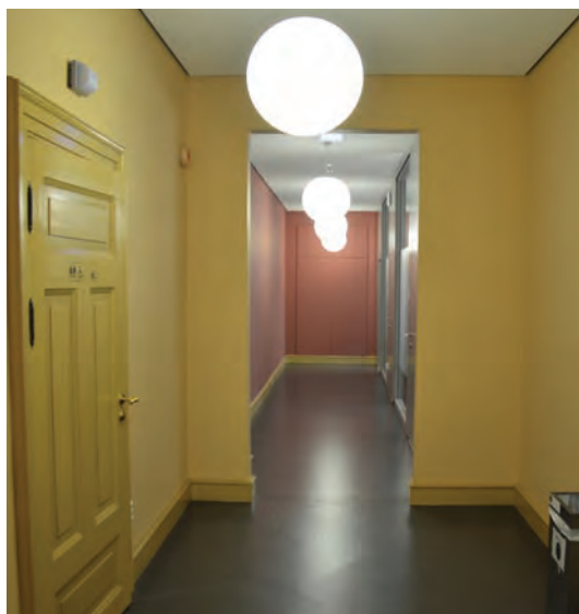
Korridorene har nyere linoleum på gulvet og nyere pendelbelysning, og veggene er pusset og malt med nyere maling.
