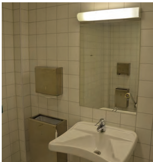
Rommet har ny sanitærrinnredning og belysning. Veggene har nyere fliser.
