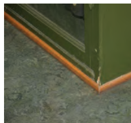
Sokkelen på skapet har fått en vaskelist. Gulvet er belagt med nyere linoleum.
