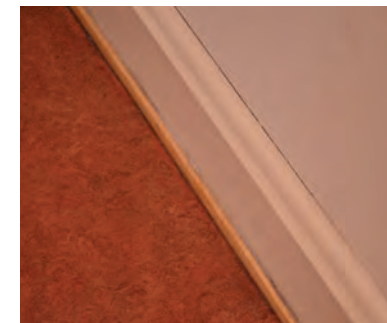
Gulvet er belagt med nyere linoleum, nyere profilert fotlist og vaskelist.
