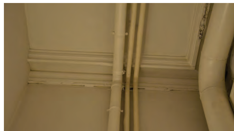
Himlingen i bøttekottet har flere rørføringer, men den eldre profilerte taklisten er bevart.
