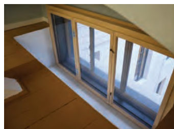
Langs fasaden er vinduene plassert under gulvnivået.
