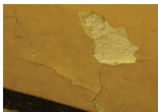
Veggene er pusset og malt.
