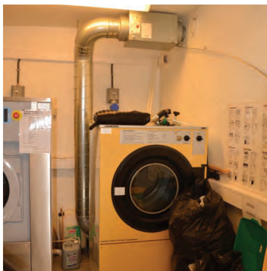
Veggene og himlingen er pusset og malt.
