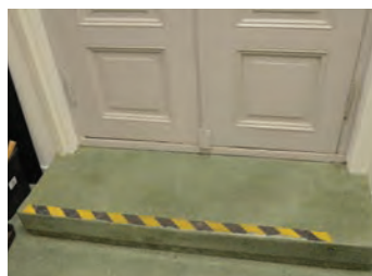
Trinn av terrazzo ned fra inngangsdør
