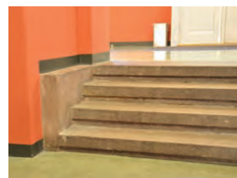
Repos er av betong og terrazzo, trinn og trappen er av granitt.
