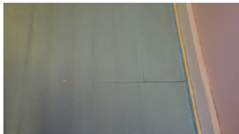
De eldre gulvbordene kan tydelig ses under linoleumsbelegget.
