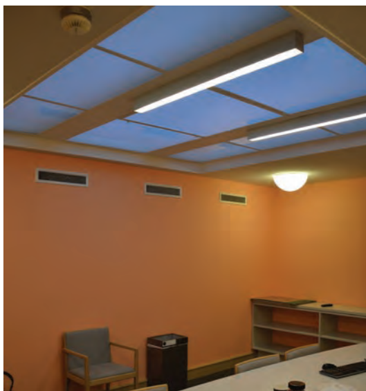
Rommet er restaurert, med nyere belysning, pussete og malte vegger og nytt ventilasjonsanlegg.
