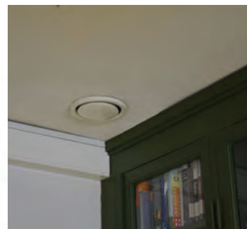
Nyere, senket himling, ventilasjonsluke
