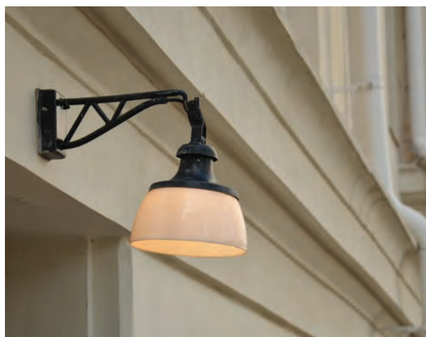
Belysning som brukes over inngangene på bygningen.
