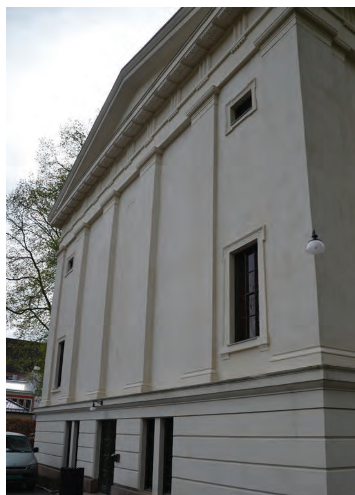
Aulaens fasade mot nordøst.
