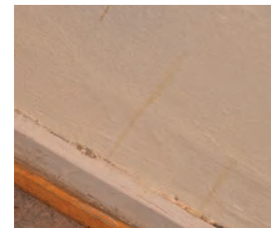
Veggen er pusset og malt.
