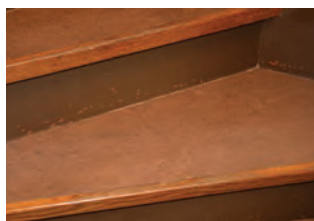
Trappetrinnene er belagt med nyere linoleum.
