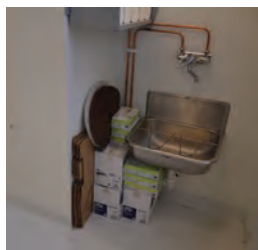
Utslagsvask på bøttekottet.
