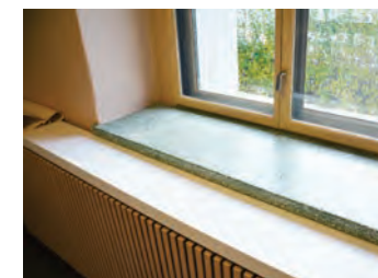
Spileverk av eik foran radiatorene under vinduene
