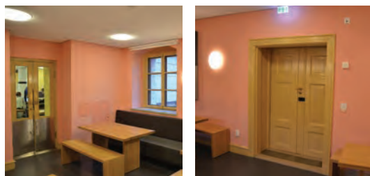
Døren er fra 1980, glasset ble skiftet ved forrige restaurering. Dør ut til korridor 022 er opprinnelig.
