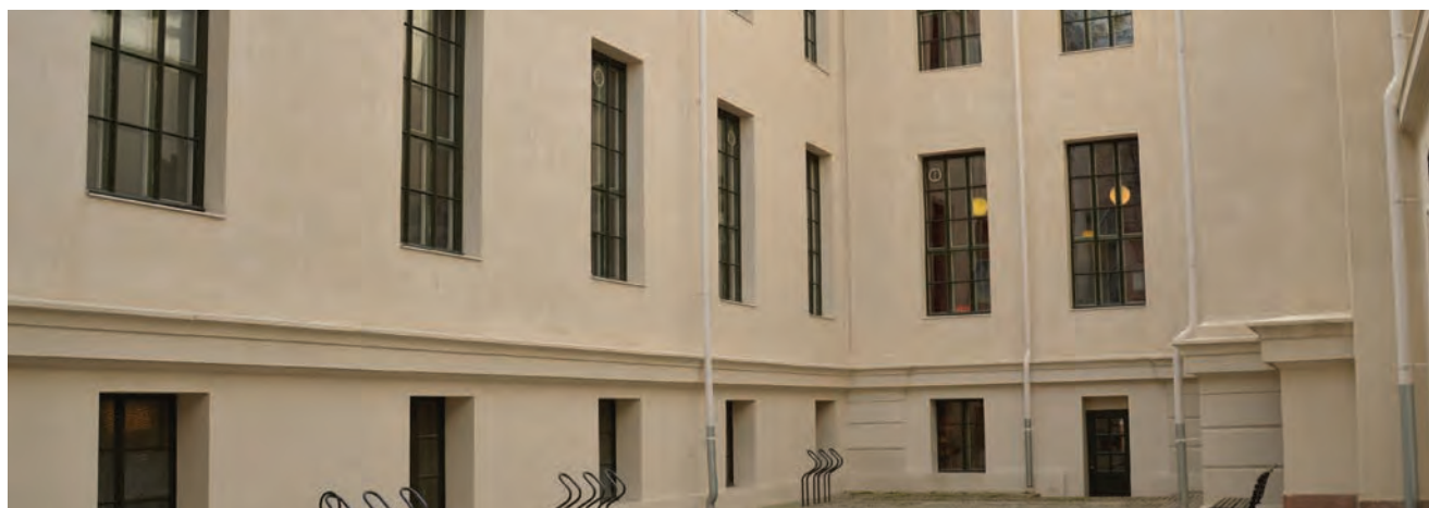
Et av de indre gårdsrommene mellom fløyene.
