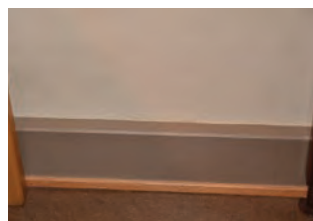
Nyere fotlist og vaskelist. Gulvet er belagt med nyere linoleum.
