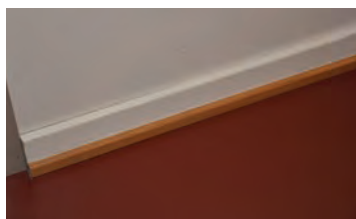
Gulvet er belagt med nyere linoleum. Nyere, glatt fotlist og vaskelist
