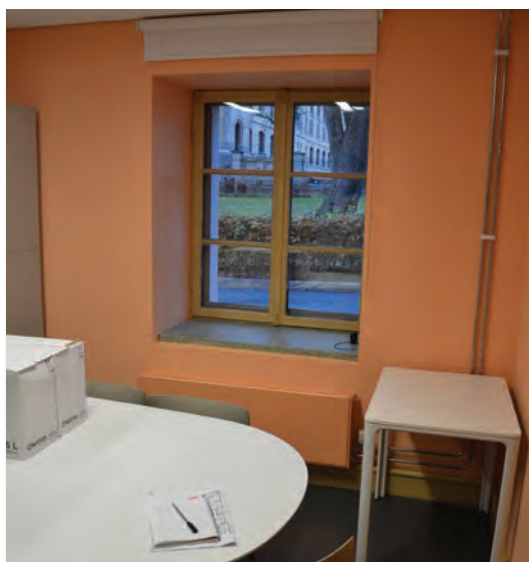
Veggene er pusset og malt. Vinduskarmen er belagt med terrazzo. Eldre varevindu på innsiden av vinduet.
