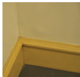
Veggene er pusset og malt, gulvet er belagt med linoleum.
