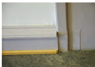
Eldre bevart fotlist og belistning rundt dør mot nabokontoret
