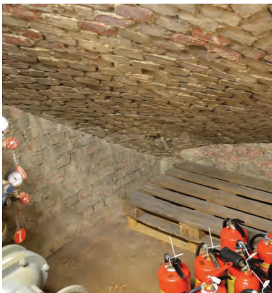
Rom 098, både himling og vegger er av teglstein, gulvet er av betong.
