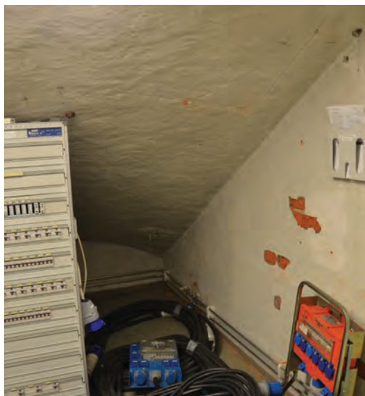
Både vegger og himling er pusset, trolig med en sementpuss.
