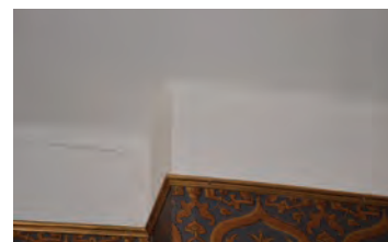
Tapetet avsluttes med en list et stykke nedenfor himlingen.
