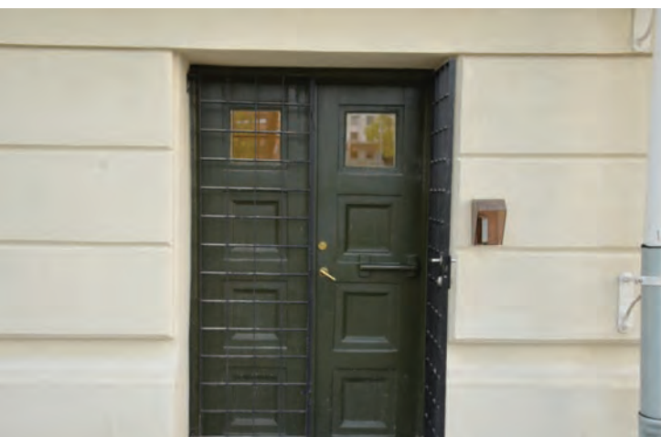
Eldre dør inn til kjelleretasjen mot nordøst.
