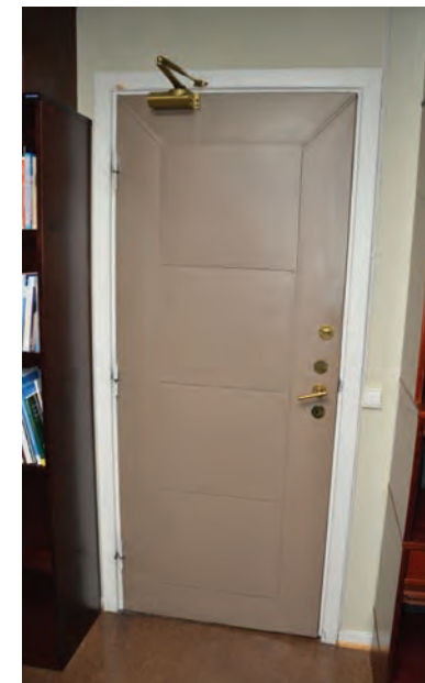
Nyere dør belagt med stålplater.
