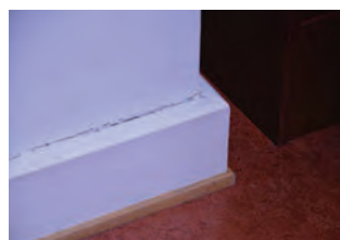
Rommet har nyere, glatte fotlister.
