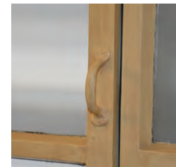
Detalj av håndtak på varevindu
