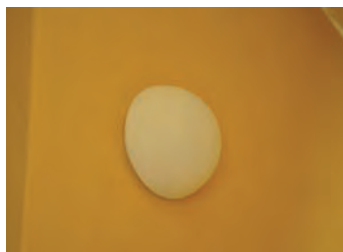
Nyere plafond av glass på veggen
