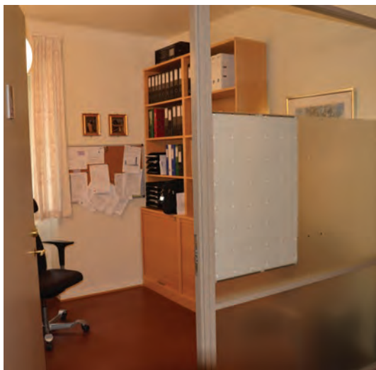
Opprinnelige, murte vegger er pusset og malt. Nyere glassvegger mot korridor og lettvegger mellom kontorene.
