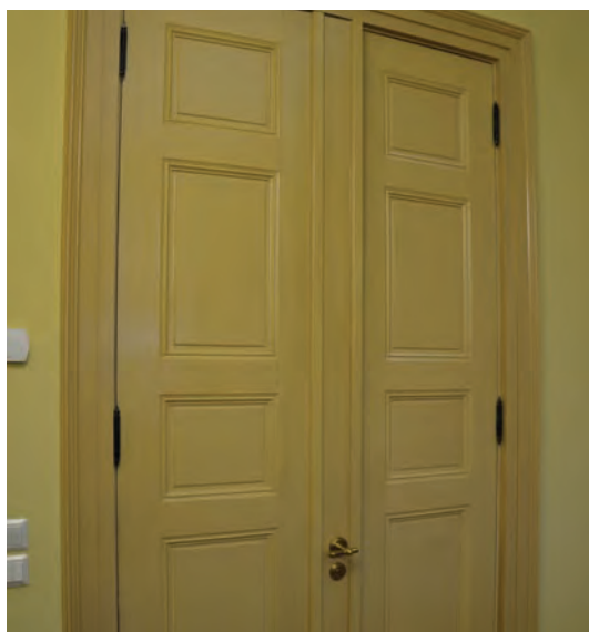
Dørene inn til rommet er kopier av de opprinnelige dørene. Malt med lasur/linoljemaling.
