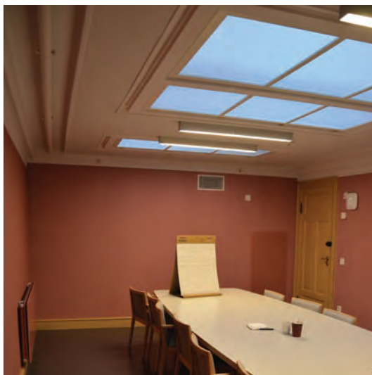
Rommet er restaurert. Gulvet er belagt med nyere linoleum, og veggene er pusset og malt.
