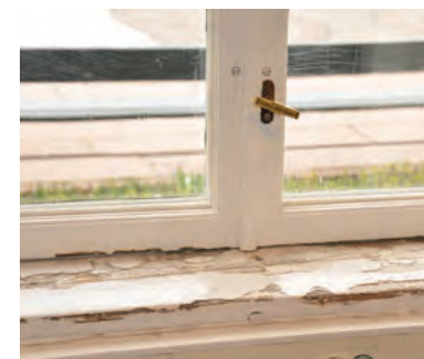
Detalj av nyere varevindu
