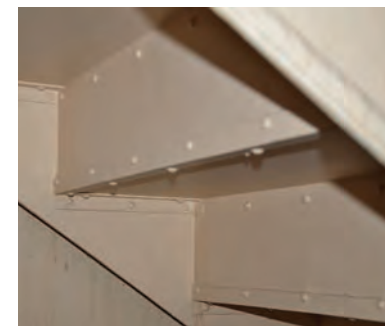
Undersiden av trappen er malt.
