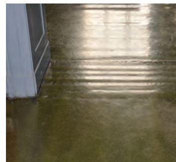
Gulvet i slusen mot kontoret
