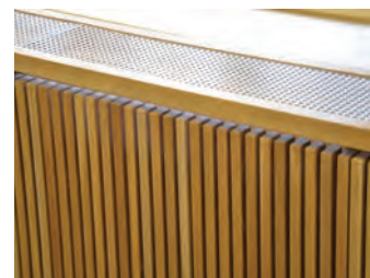
Nyere spileverk foran radiatorene under vinduene
