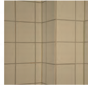
Veggene er flislagt med nye fliser.
