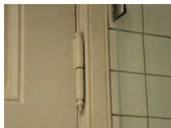
Døren fra wc til korridoren har opprinnelige hengsler.
