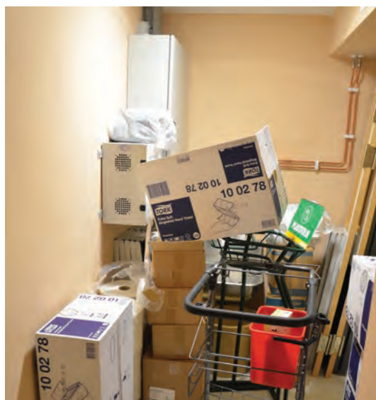
Rom 029 sett fra trapperommet. Veggene er pusset og malt, gulvet har nytt vinylbelegg.
