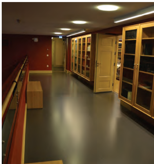
Korridoren har nytt linoleumsgulv, rekkverk av glass og tre og nye bokskap av eik.
