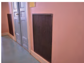
Veggen er pusset og malt.
