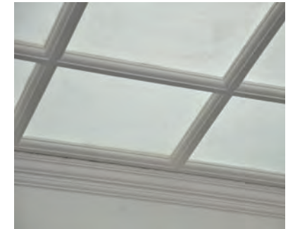
Overlysfelt med sprosdedelt glass
