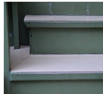
Linoleumsbelagte trinn på hver side av benkene
