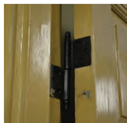
Eldre dør med originale hengsler
