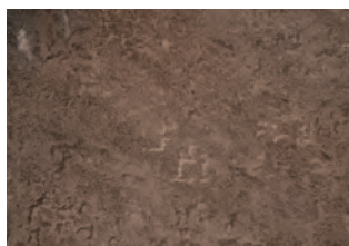
Gulvet er belagt med nyere linoleum.
