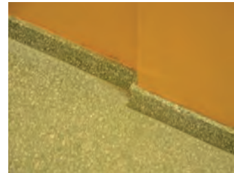
Gulvet er belagt med terrazzo.
