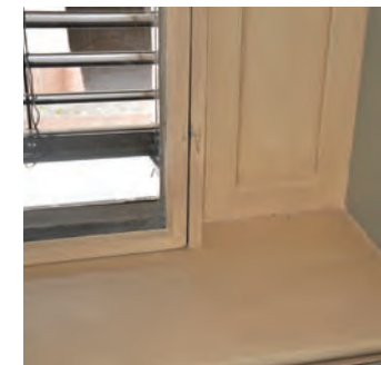
Detalj av vinduskarm, malt med linoljemaling.
