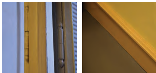
Opprinnelige hengsler på vindu og varevindu i kontor 227
