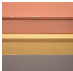
Gulvet er belagt med nyere linoleum. Linoljemalt fotlist
