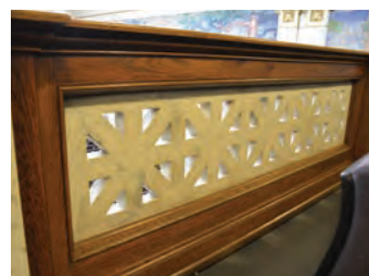
Rekkverk av marmor og lakkert tre mot salen
