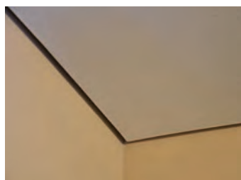
Himlingen består av nye, akustiske plater som er pusset og malt.
