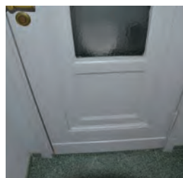
Døren til WC er trolig opprinnelig.
