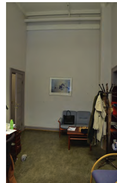
Kontor 151B sett mot slusen. Døren til venstre er en kopi, satt inn i en nyere lettvegg.
