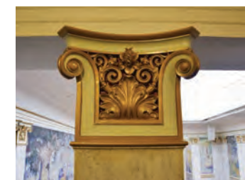
Kapitelet på søylen er joniskinspirert, med forgylte detaljer.
