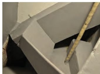
Himling i lageret med nyere ståldragere
