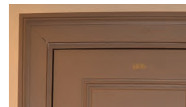
Nyere dør og gerikter inn til teknisk rom
