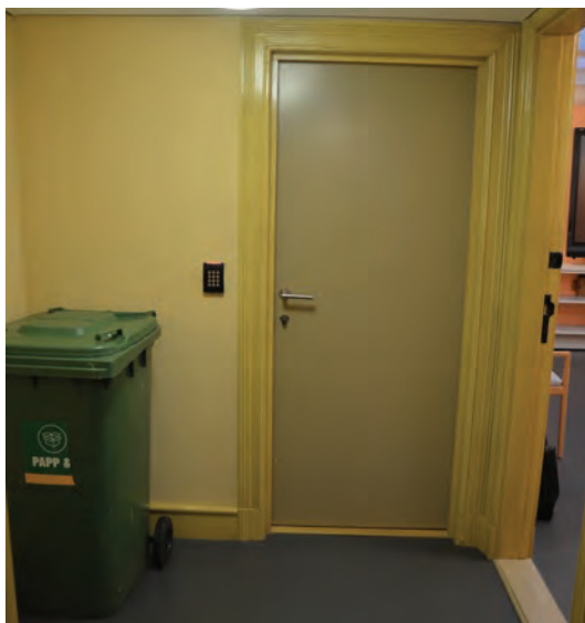
Korridoren mellom møterommet og telematikkrommet
