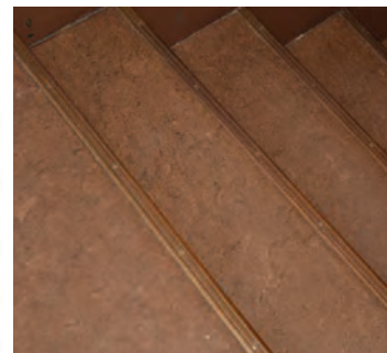
Trappetrinnene er belagt med nyere linoleum. Beslag av metall på trappnese.
