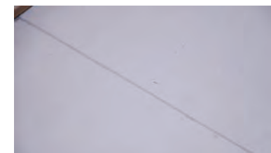
Gulvet er belagt med eldre linoleum.
