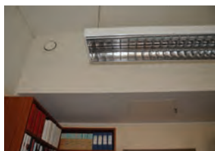
Kontorene har nyere belysning. Mot korridoren er himlingen senket, for å skjule opplegg for ventilasjon.
