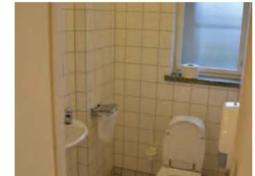
Rommene har nyere toalettbasen med spanskvegger av laminat.
