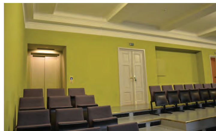
Gulvet og trinnene er belagt med nyere linoleum og har nedfelt belysning.
