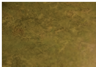
Gulvet er belagt med nyere linoleum.
