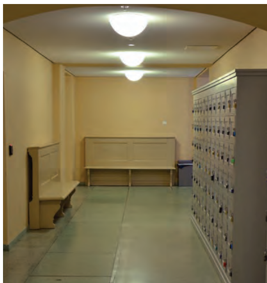
Korridor 006 sett mot 013. Himlingen har nyere, akustiske plater, gulvet er av terrazzo og veggene er pusset og malt. Eldre bokskap og benker langs veggene.
