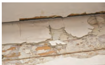
Detalj av vinduskarmen
