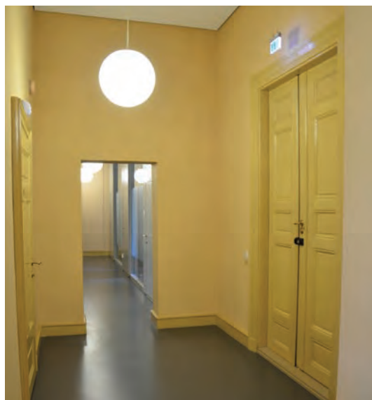
Korridorene har pusete og malte vegger. Gulvene er belagt med nyere linoleum.
