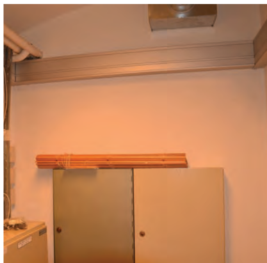
Veggene er pusset og malt, lettvegg er malt.
