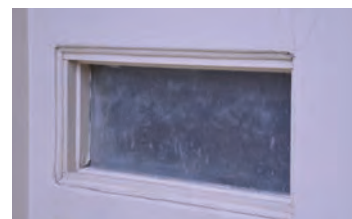
Eldre glassfelt over dør med profilert karm
