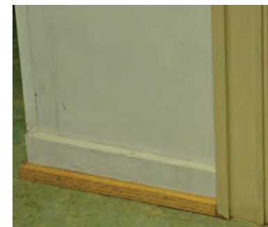
Rommet har nyere fotliaster og vaskelister.
