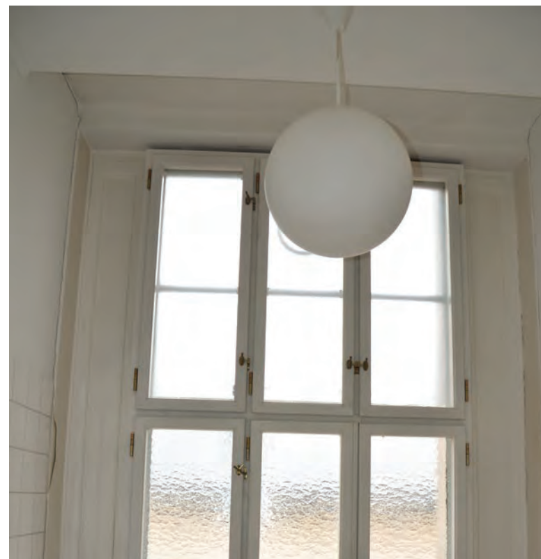
Nyere varevinduer med ruglete glass. Karmen er belagt med en malt treplate.
