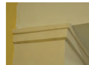
Pussete og malte profiler på pilaster
