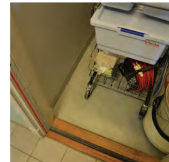
Gulvet i kottet er belagt med vinyl.
