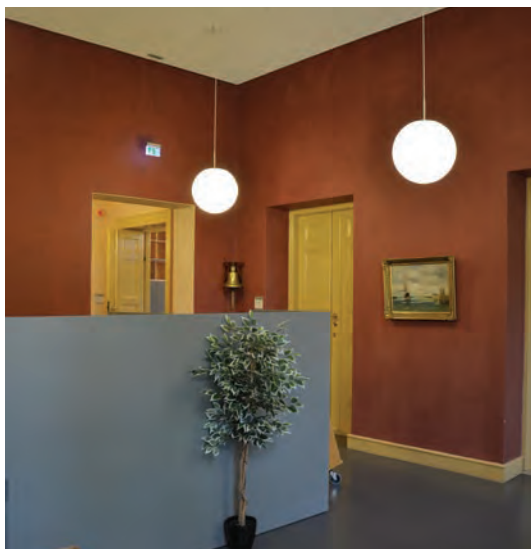
Korridoren har nyere, senket himling med ny pendelbelysning. Gulvet er belagt med linoleum.
