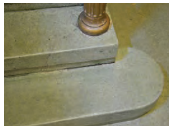
Trinn av betong og terrazzo
