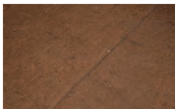
Gulvet er belagt med nyere linoleum.
