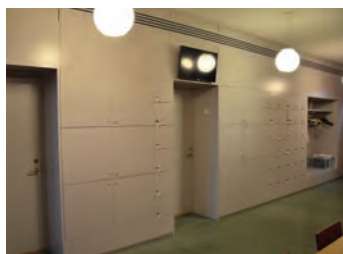
Veggen er dekket av nyere skap av laminat.
