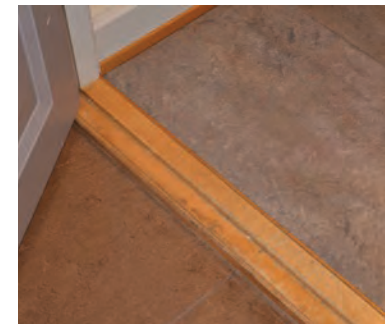
Gulvet er belagt med nyere linoleum.
