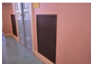
Eldre ventilasjonsrister på veggen
