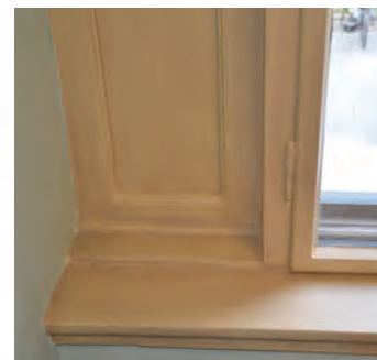
Detalj fra vinduskarm i rom 107
