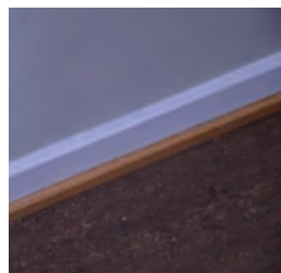
Gulvet har nyere linoleum, fotlist og vaskelist.
