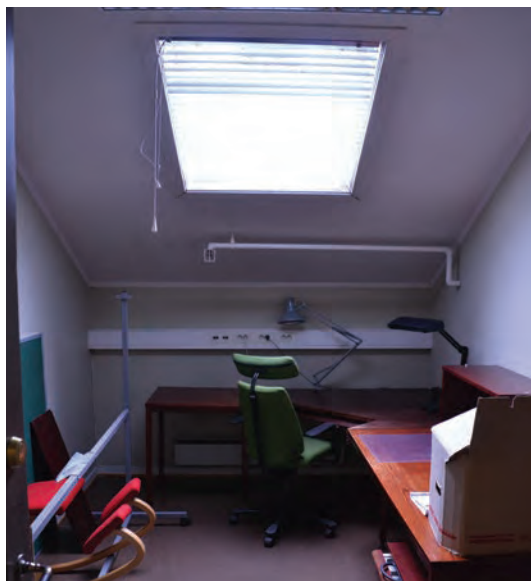
Nyere takvindu i himlingen
