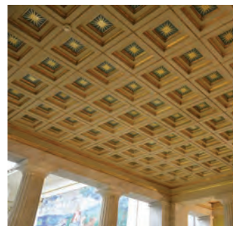
Kassetthimling støttes av marmorsøyler.
