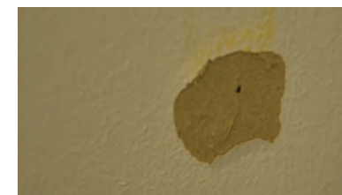
Veggen mellom kontorene er kledd med nyere, malte plater.
