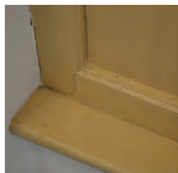
Detalj fra eldre vinduskarm inne på kottet.
