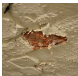
Teglsteinen er trolig malt med en plastbasert maling.
