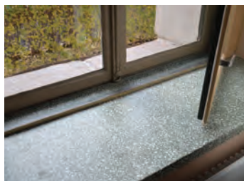
Vinduskarmen på lageret i rom 001A er av terrazzo.
