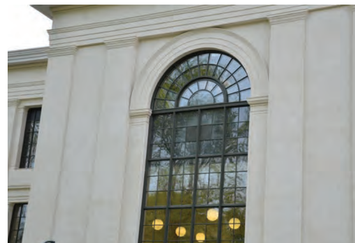
Vindu på vestfløyen mot hagen.
