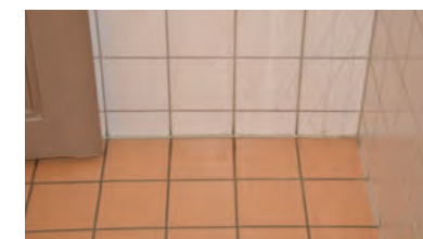
Gulv og vegger på dametoalettet
