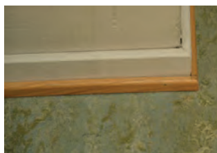
Gulvet har nyere linoleum, glatt fotlist og vaskelist.
