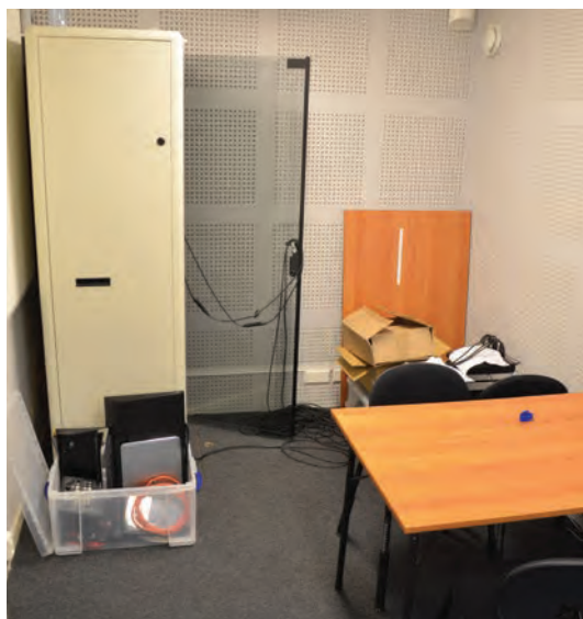
Rommet sett fra slusen. Teknisk skap til venstre
