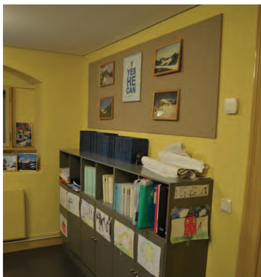
Veggene er pusset og malt, og himlingen er senket.
