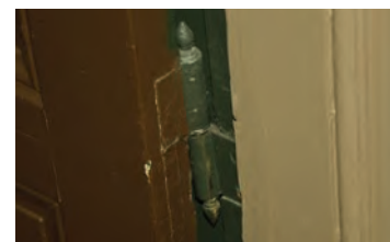
De eldre dørene har bevart opprinnelige hengsler.
