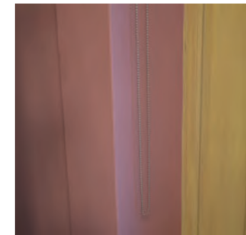
Veggene er pusset og malt.
