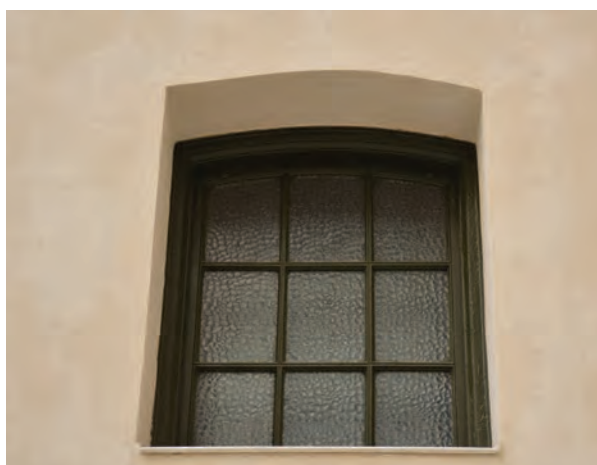
Eldre vindu ut mot det indre gårdsrommet.
