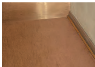
Gulvene er belagt med nyere linoleum.
