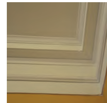
Opprinnelig, profilert taklist
