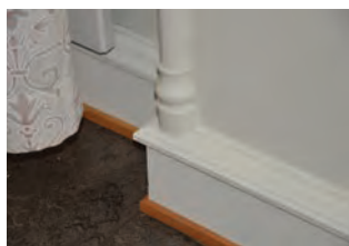
Høy, profilert fotlist av malt tre
