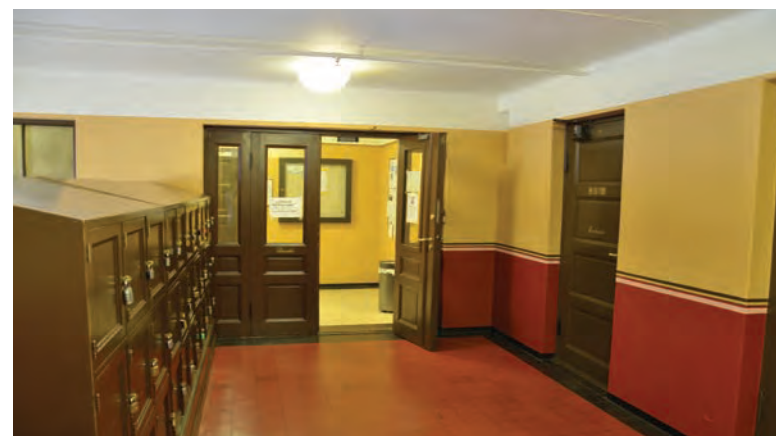
Korridor mot lesesalene i 3. (1.?) et. Gulvet er flislagt med fliser i ulike farger. Dørene er opprinnelige, men har fått dørpumper i nyere tid.
