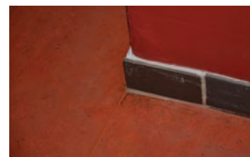
Gulvet er belagt med nyere linoleum.
