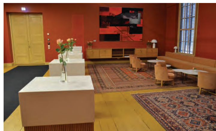
Fotlisten er malt med lasur/linoljemaling. Veggen er pusset og malt.
