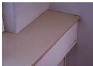
Vinduskarmen er belagt med malt plate av tre.
