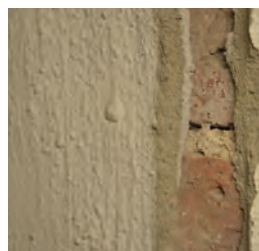
Synlig teglstein med fuger av kalkmørtel
