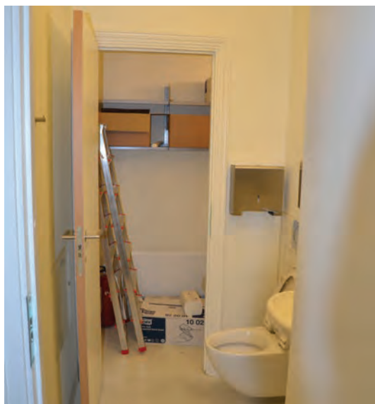
Rom 121 B og C. Rommene har nyere gipsvegger og nye overflater.
