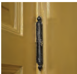
Opprinnelige hengsler til rom 106
