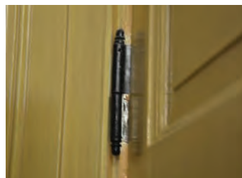
Originale hengsler på døren til kontor 231 er fra ca. 1880.
