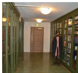
Himlingen i korridoren er senket og har nyere belysning.
