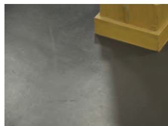
Gulvet er belagt med nyere linoleum.
