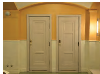
Opprinnelige dører til toalettene
