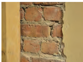
Opprinnelig teglmur med fuger av kalkmørtel
