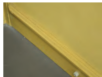
Gulvet er belagt med nyere linoleum.
