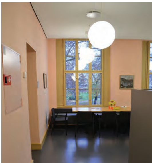
Den tidligere lesesalen blir i dag brukt til spiserom. Gulvet er belagt med nyere linoleum, himlingen er senket med akustiske plater, pusset og malt. Vegger er pusset og malt, nyere maling.
