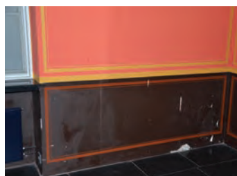
Veggene er pusset og malt.
