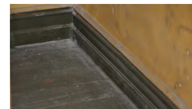
Gulvet og veggen inne på lageret
