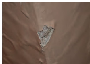
Veggene er pusset og malt med nyere maling.
