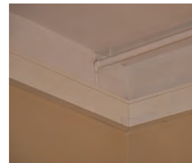
Himlingen og veggen er pusset og malt.
