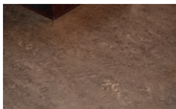
Gulvet er belagt med nyere linoleum.
