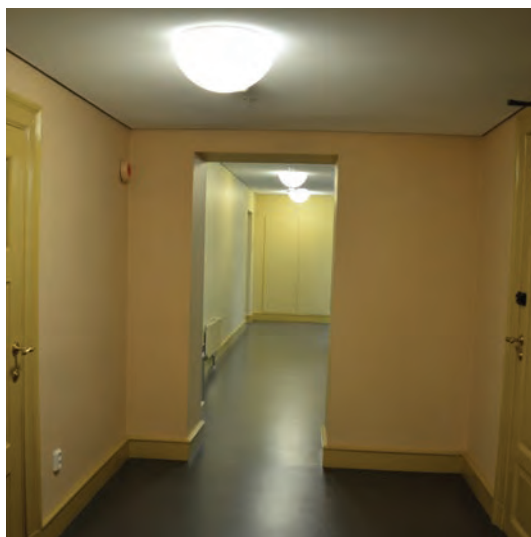
Den første delen av korridoren var tidligere oppdelt i to små garderobes. Himlingen har nye, akustiske plater, nye plafonder, nytt linoleumsgulv og pussete og malte vegger.
