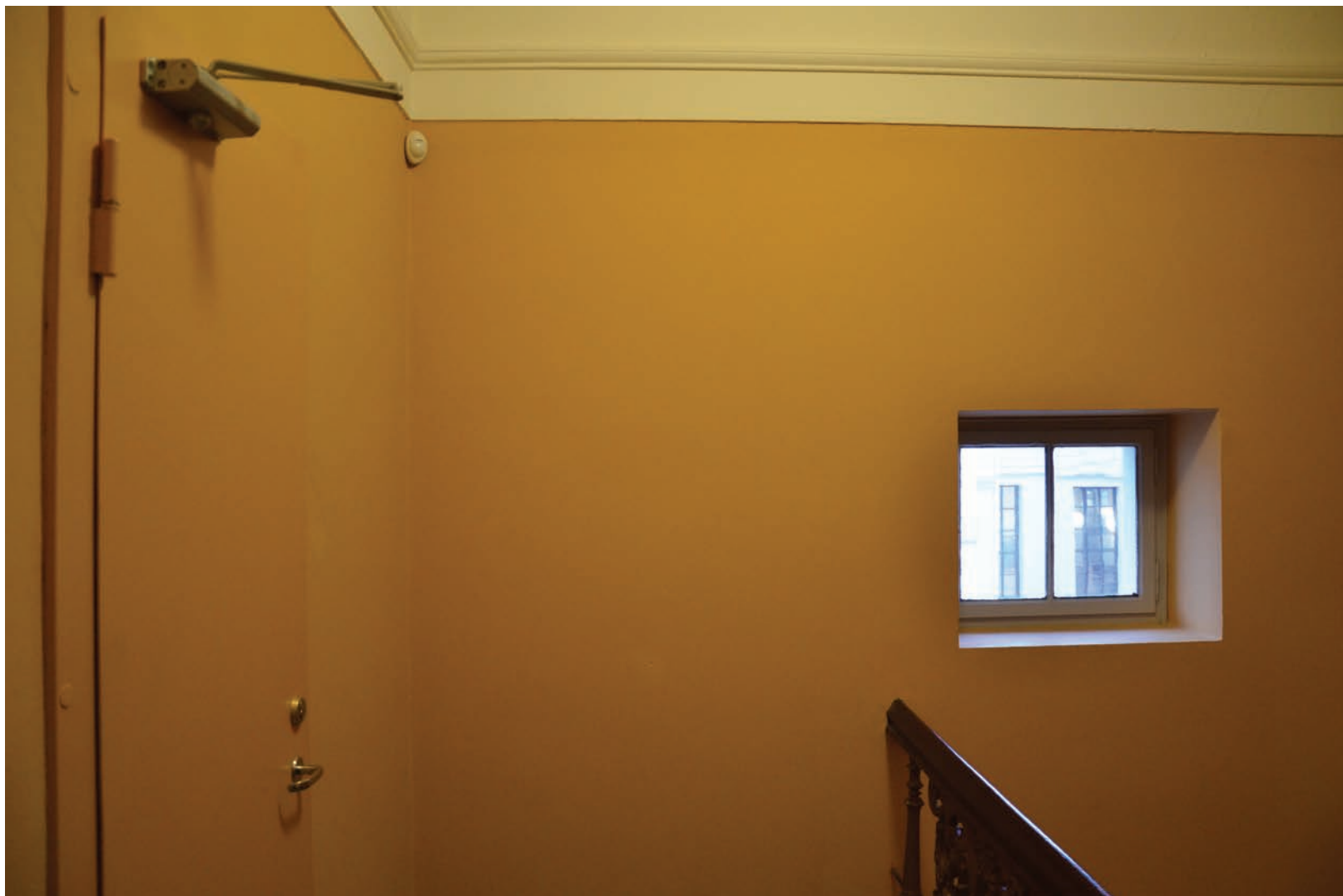
Øverst i trapperommet, dør til teknisk rom til venstre
