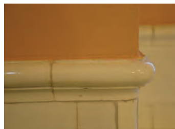
Veggene er belagt med fliser.
