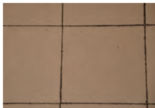
Detaljfoto av gulvflisene
