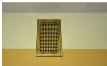
Eldre ventilasjonsrist av messing
