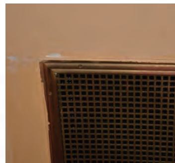
Eldre ventilasjonsrist på veggen
