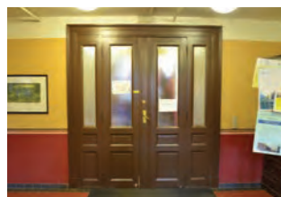
Eldre dører mot trapperom, med glassfelt
