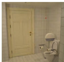
WC 011A sett mot døren til 011, bøttekott.
