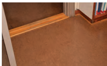
Gulvet er belagt med nyere linoleum.
