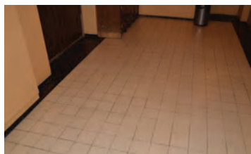
Gulvet er belagt med eldre fliser.
