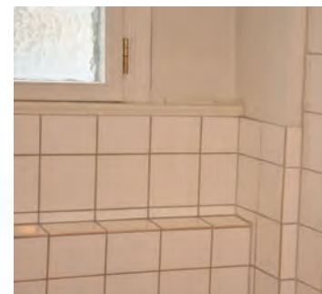
Flislagt avtrapping under vindu på HC WC
