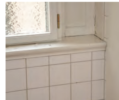
Nyere varevinduer med ruglete glass. Karmen er belagt med en malt treplate.
