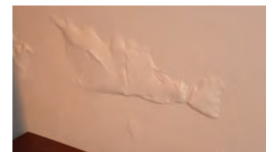
Veggene er pusset og malt med nyere maling.
