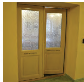
Nyere dør av furu med glass
