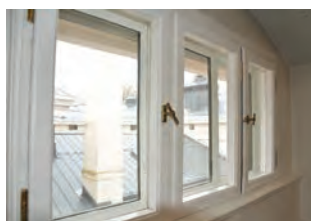
Nyere varevinduer på innsiden
