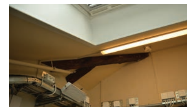
Opprinnelige bjelker og nyere armatur
