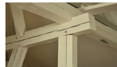
Opprinnelige stolper og bjelker, malt med nyere maling.
