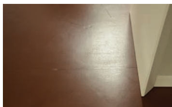
Gulvet er belagt med nyere linoleum.
