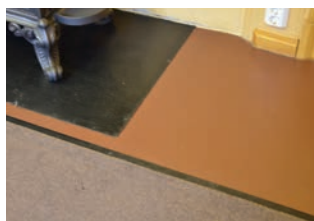
Gulvet er belagt med nyere linoleum.
