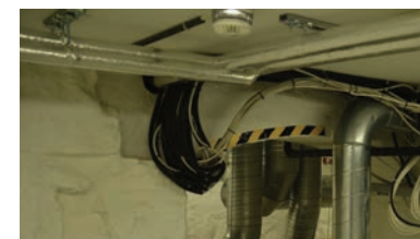
Himling av betong med nye tekniske føringer
