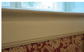
Undersiden av vinduskarmen, profilert og malt med linoljemaling.
