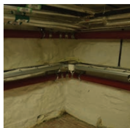
Natursteinsvegger med nyere teknisk anlegg
