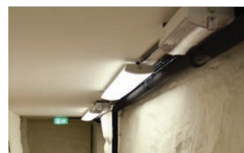
Himling med malt betong og nyere lysarmatur
