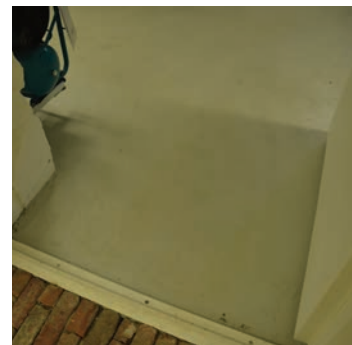
Malt betonggulv i de tekniske rommene
