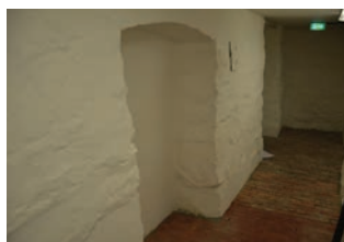
Gjenmurt døråpning i korridor 019
