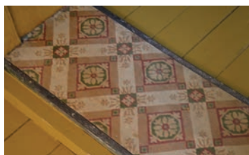
Terskel mellom stuene med mønstret linoleum
