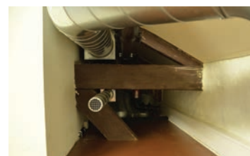
Opprinnelige bjelker og nyere ventilasjonsrør
