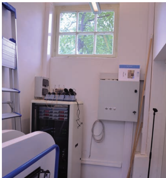
Opprinnelig vindu plassert høyt på veggen.
