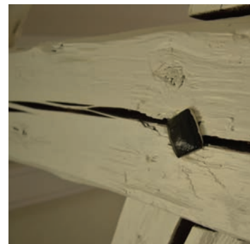
Opprinnelige bjelker med nyere maling
