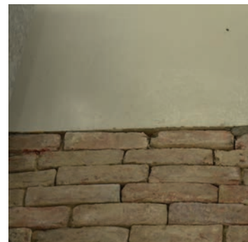
Gulv belagt med tegl og malt betong.
