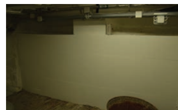
Vindusåpningene er igjenmurt, veggen er trolig forsterket med ny betong.
