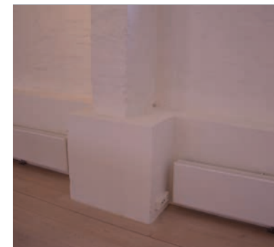
Sokkelen over gulvet er kalkpusset.
