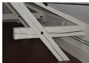
Opprinnelig, malt bjelke
