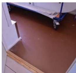
Gulvet er belagt med linoleum.
