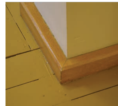
Fotlist av furu, malt med linoljemaling.
