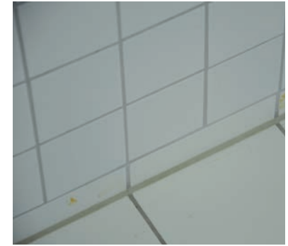
Overgang mellom gulv og vegg
