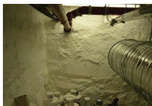
Nyere, teknisk anlegg
