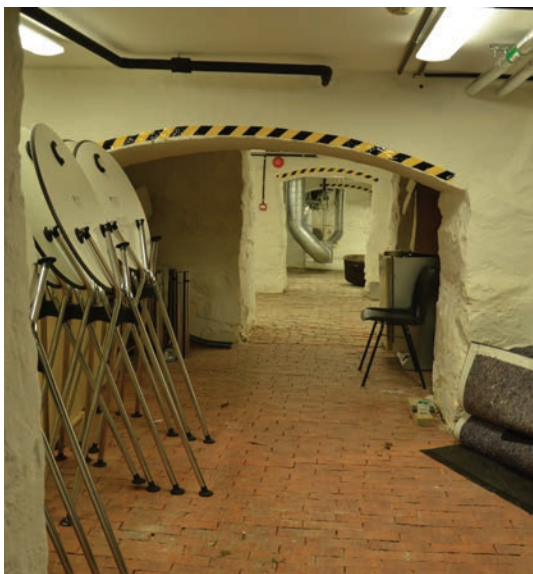
Rom 013, bakover ligger rom 014 og 015.
