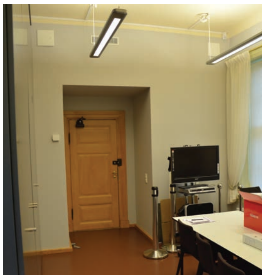
Opprinnelig dør til entréen
