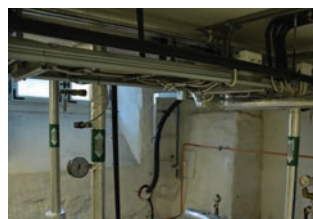
Nyere teknisk anlegg
