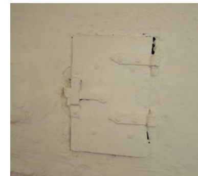
Opprinnelig sotluke i veggen
