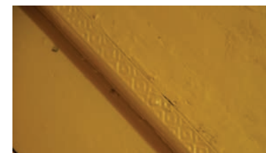
Detalj av beslag på terskel ut til korridoren
