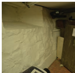
Eldre vindusåpning er murt igjen.
