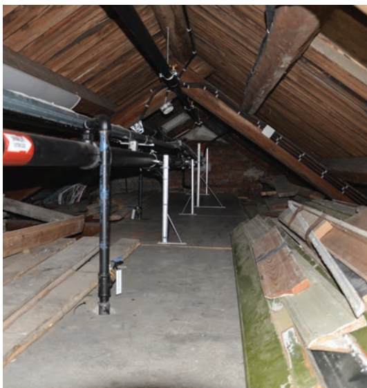
Rommet 212 sett fra rom 202.
