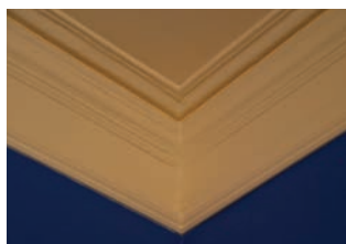
Profilert taklist, en kombinasjon av trukket gips og taklist av gran som nederste profil.
