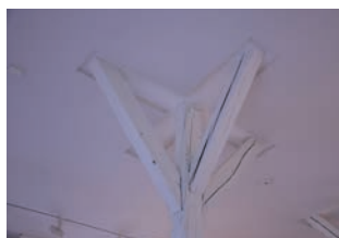
Himlingen er kledd med nyere plater.
