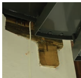
Synlige, opprinnelige bjelker
