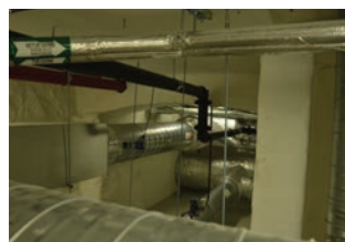
Nyere, teknisk anlegg
