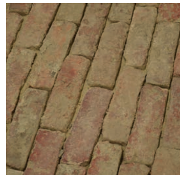
Gulvet er belagt med teglstein satt i sand eller leire.
