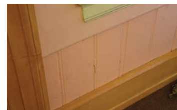
Opprinnelig panel under vinduet
