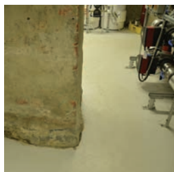
Gulvet er av betong. Opprinnelig mur til venstre
