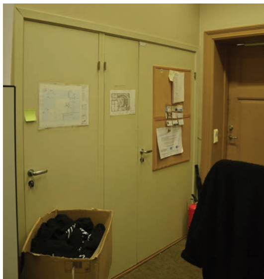
Kontoret sett mot rom 100 til høyre. Nyere teknisk skap til venstre
