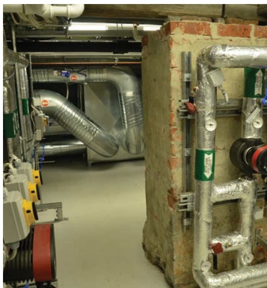
Rom 002 med teknisk utstyr. Muren av tegl til høyre er trolig opprinnelig.
