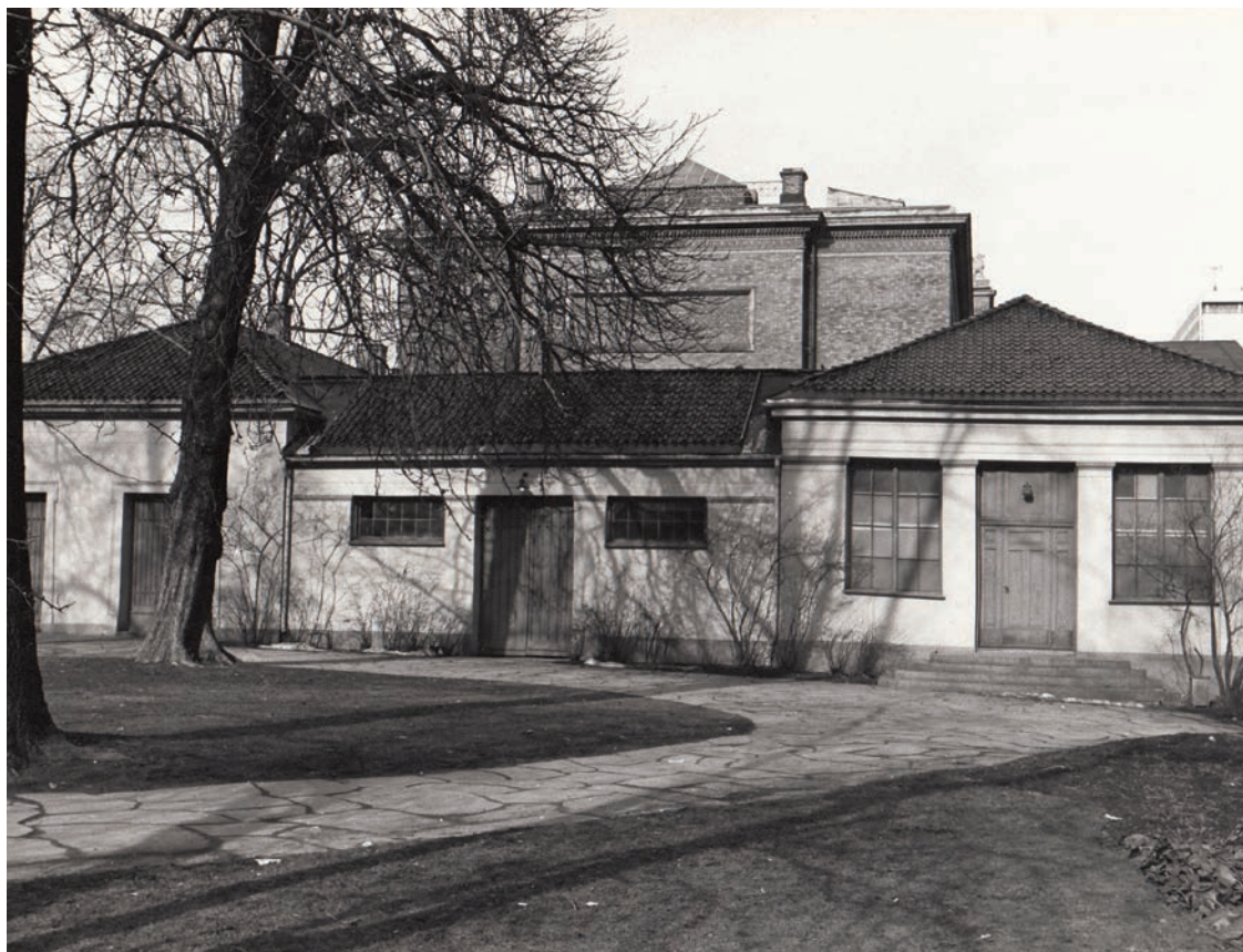
Bilde av Gymnastikkbygningen fra 1979. (Foto: Jan Andersen, Riksantikvarens arkiv)
