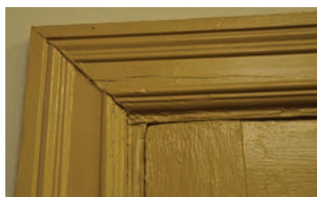
Opprinnelige gerikter rundt dør
