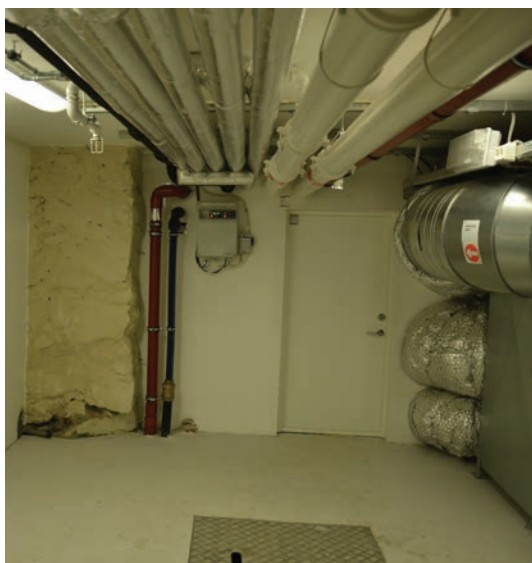
Rom 001. Den opprinnelige muren er synlig til venstre.
