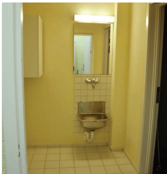
Rom 107B sett fra rom 105. Nye overflater og innredning
