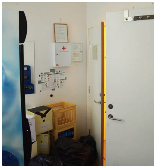
Lageret med nye overflater og innredet WC og dusj.
