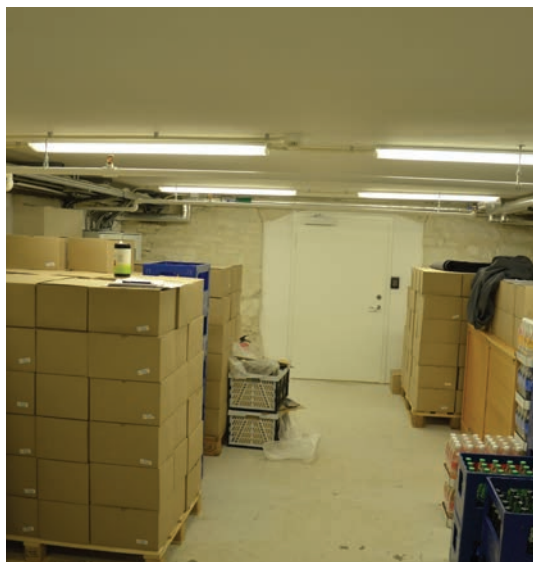
Rom 001B. Malt betonggulv, nyere belysning
