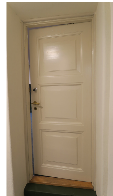
Døren til 301 sett fra utsiden.
