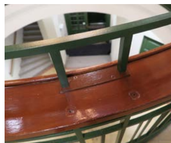
Den øverste grønne delen er fra 2020, for å bedre sikkerheten.
