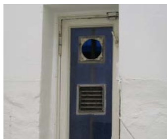
Opprinnelig vindu mot vest i rom 126B.
