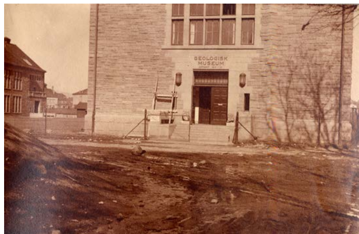
Gravearbeider utenfor bygningen i 1922. Fotograf: Ukjent. Kilde: Museum for universitets- og vitenskapshistorie.
