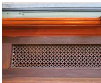
Opprinnelig metallrist over radiator.
