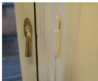
Opprinnelig hengsel til tidligere varevindu til høyre.
