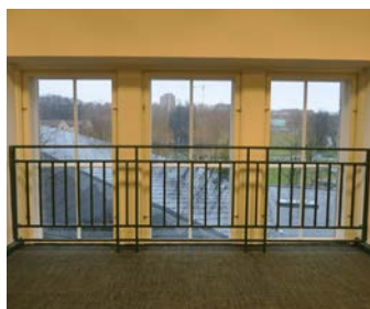
Vinduer på fasade mot øst. Nytt rekkverk foran.
