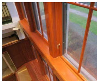
Detaljbilde av vinduene mot vest.
