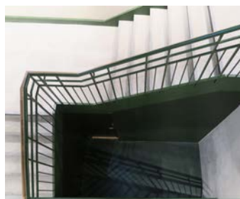
Trapperommet fortsetter ned til 2. etasje.
