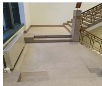
Repos mellom 1. og 2. etasje.
