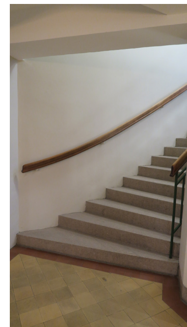
Trappen opp til 3. etasje.
