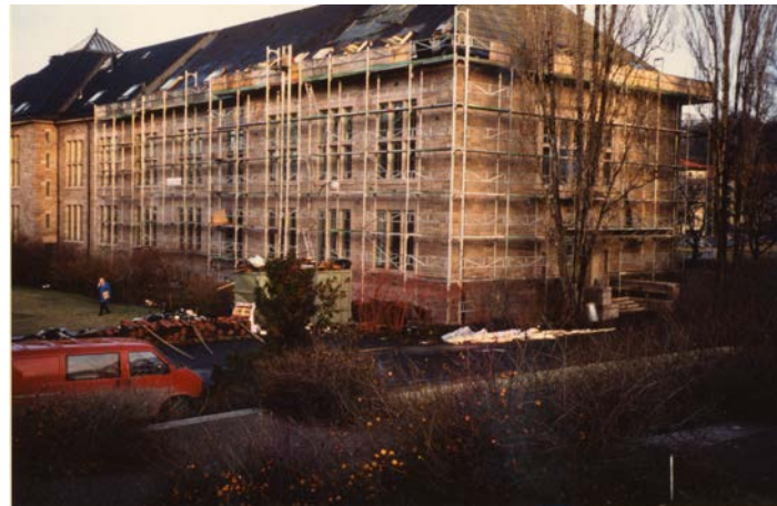
Brøggers hus sett fra sørvest, 1991. Bildet er tatt i forbindelse med arbeidet med taktekkingen. Foto: Johannes Dons/ MUV.
