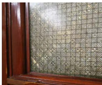
Opprinnelig trådglass i dørene mot vestibylen.
