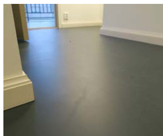
Gulvet er belagt med ny linoleum.
