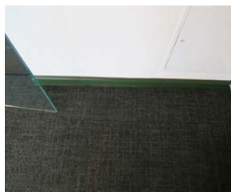
Vegg til vegg teppe på gulvet.
