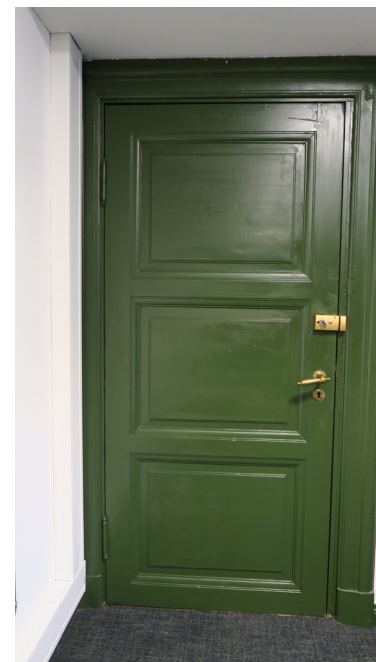
Dør til 311 korridor.
