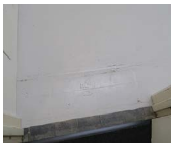
Gulv av malt betong i 126B.
