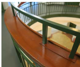
Rekkverk rundt åpningen, den øverste delen er ny.
