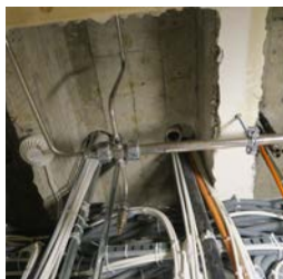
Himling/etasjeskille av betong i rom 206.
