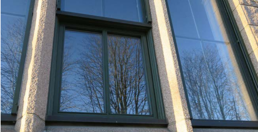
Enkelte vinduer har nyere åpningsvindu fra 1980-tallet.
