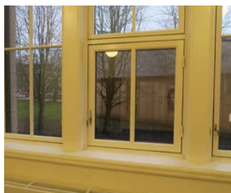
Nyere åpningsvindu fra 1980-tallet i midten.
