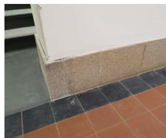
Opprinnelige fliser på gulvet og granitt nederst på veggen.
