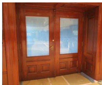
Opprinnelige dører mot rom 231.
