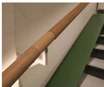
Håndløper av tre.
