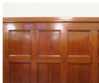
Opprinnelig panel på veggene.
