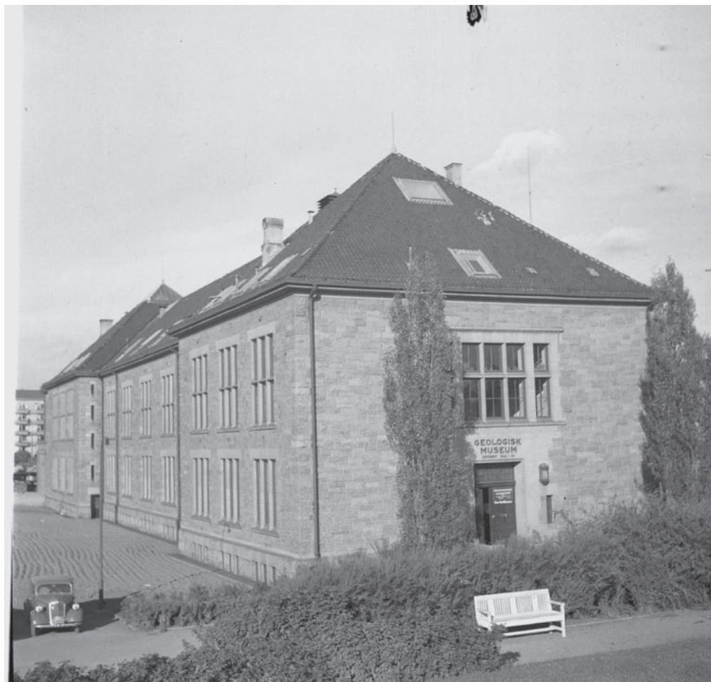
Brøgers hus med gavlfasaden mot sør, og vestfasaden. Til venstre for bygningen er det jord med ployde renner, området ble trolig fortsatt brukt til potetdyrking slik som under krigen. Bildet er fra ca. 1945-1950. Bilen i venstre hjørne er antakelig Halvor Rosendahl sin. Fotograf: Ukjent. Kilde: Museum for universitets- og vitenskapshistorie.
