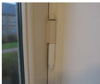
Opprinnelig hengsel på vindu, i rom 213 bøttekott.
