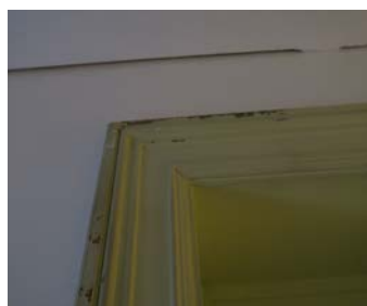
Opprinnelige gerikter rundt dørfals mot rom 103 (stengt).
