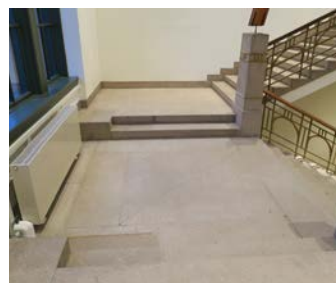
Midtrepos mellom trappeløpene.
