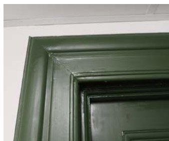
Opprinnelige gerikter rundt dør.
