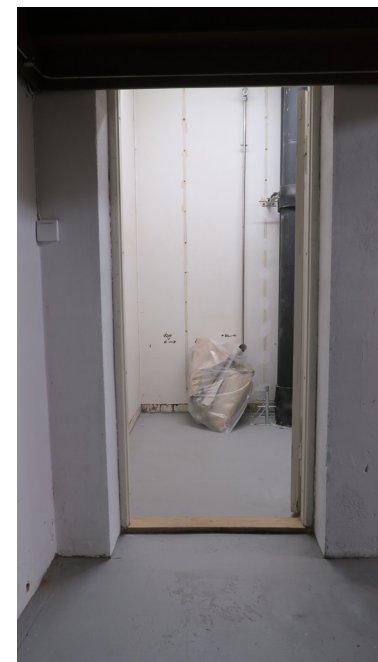
Døråpning til rom 268 lager.
