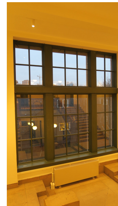
Vindusfelt mot øst.
