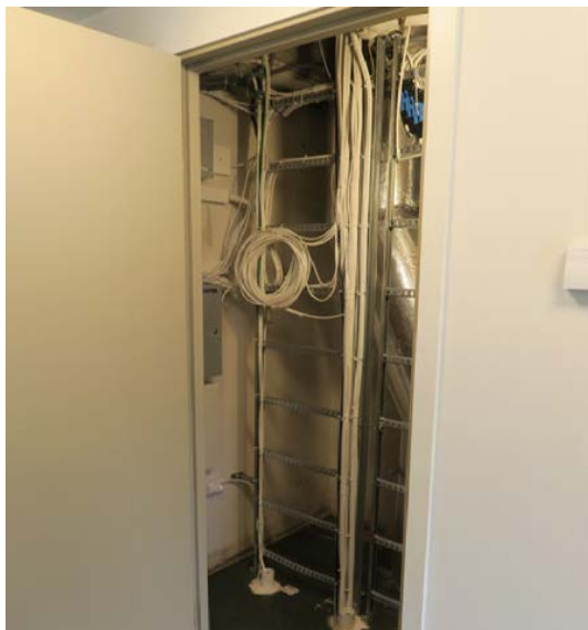
Over: Teknisk rom sett fra rom 305.
