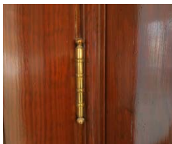
Leddhengsel av messing på en av dørene.
