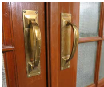
Håndtak av messing på dørene mot vestibylen.
