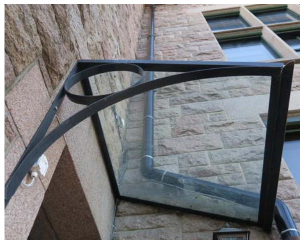
Eldre tak av glass av metall over inngang mot øst.
