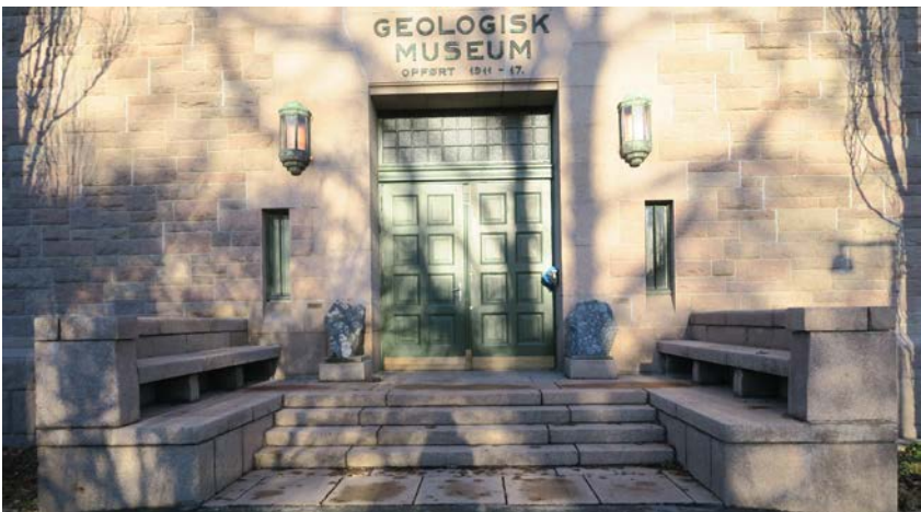
Trapp av granitt mot sør. Benker på repos på hver side av trappen.
