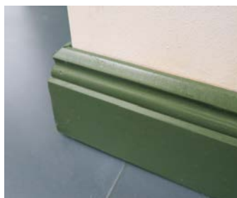
Ny linoleum og fotlist i vestibyle 391.
