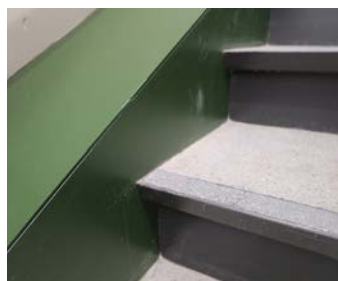
Trinn og vanger til trappen.
