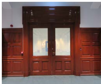
Tofløyet opprinnelig dør med tråd-glass.
