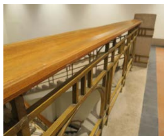
Rekkverk og håndløper mot trappe-rommet.
