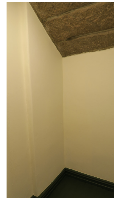
Liten gang mellom 321 og 301. Undersiden av granittrappen er synlig.
