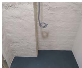
Gulv av ny linoleum i rom 126A.
