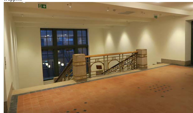
En av to meglere av granitt på hver side av trappen.
