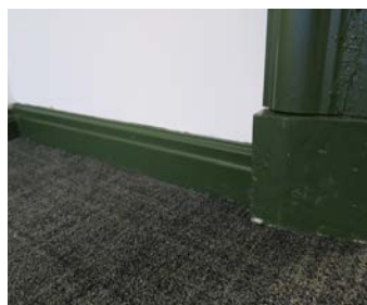
Gulvet er belagt med nytt teppe.
