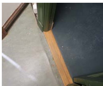
Linoleumsbelegg, rom 101 til venstre og rom 102 til høyre. Ny terskel.
