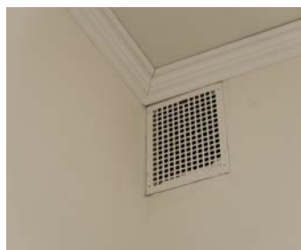
Øverst på veggen er det en opprinnelig ventilasjonsrist.
