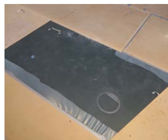
Gulvet er belagt med ny linoleum.
