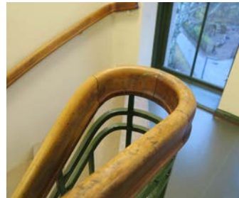
Håndløper av tre.
