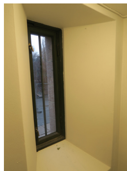
Opprinnelig vindu mot sør.
