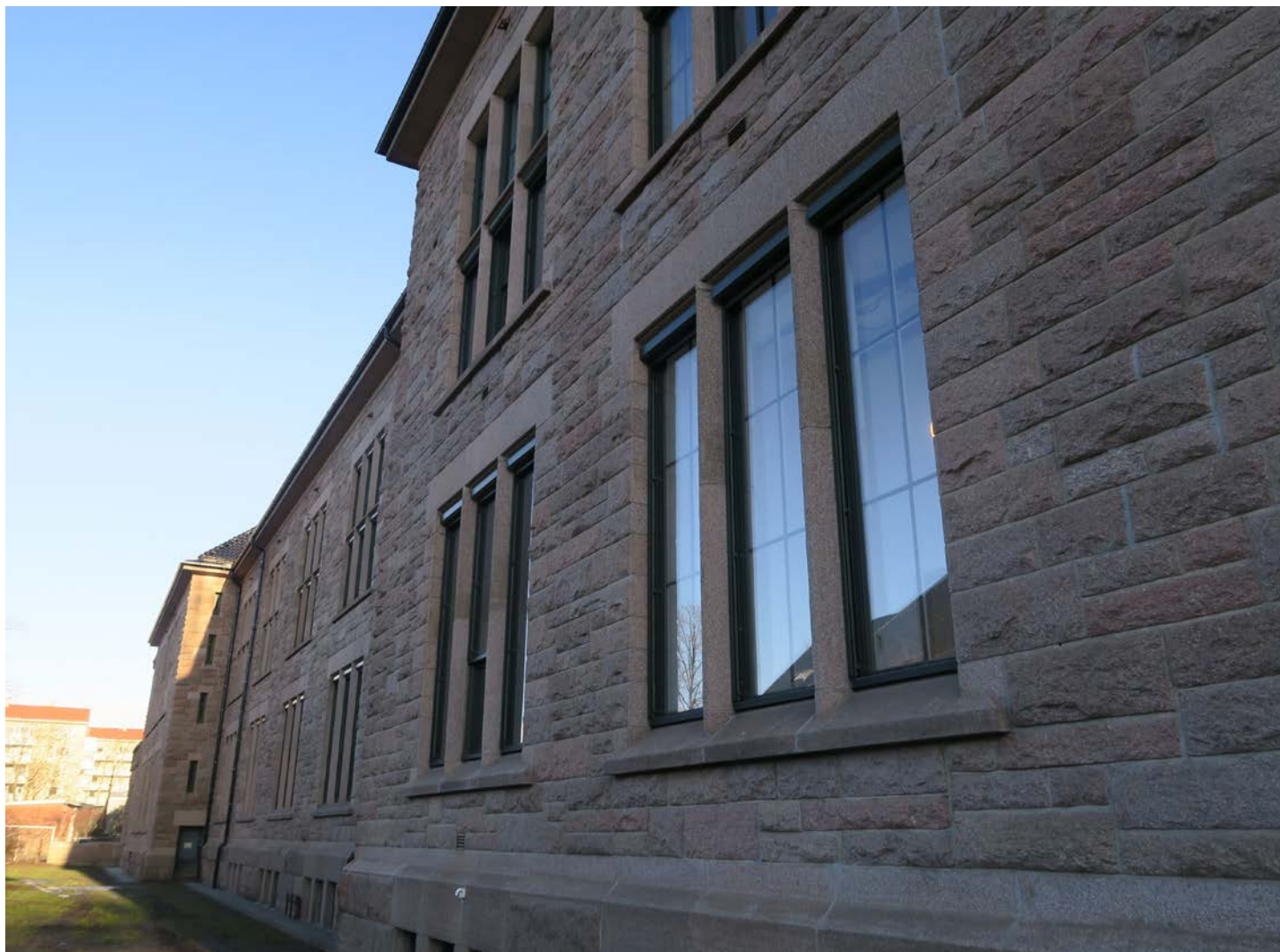
Bygningens fasade mot vest, sett mot nord.
