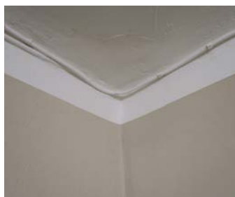
Veggene er sandfarget, himlingen lys.
