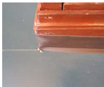
Gulvet er belagt med ny linoleum.
