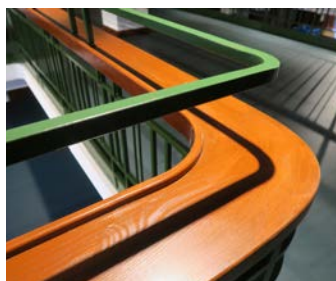
Opprinnelig rekkverk, den øverste grønmalte delen er ny.
