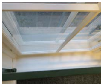
Vinduene mot vest har originale varevinduer på innsiden.
