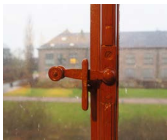
Opprinnelig vindushaspe på vindu mot vest.
