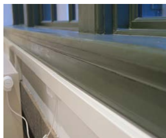
Profilert gerikt under vinduet mot øst.
