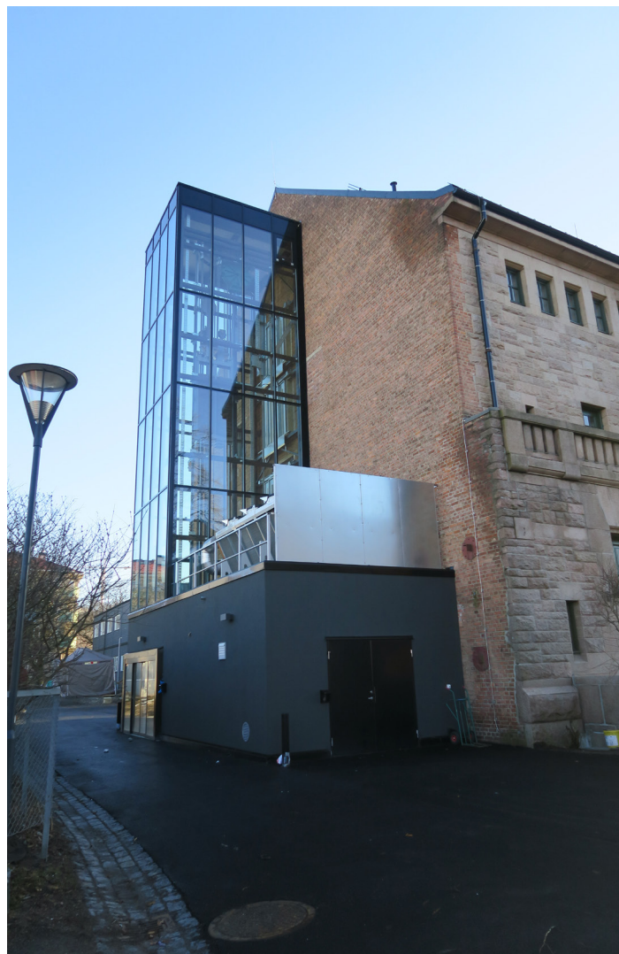
Nytt tilbygg med vareheis mot nord.
