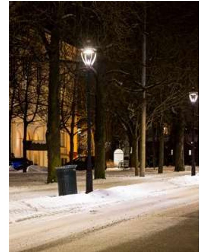
Figur 46 Inspirasjonsbilder for strekningen, viser parkarmatur med rundtstrålende lysfordeling økt lysnivå og god avblending av lyskilde
