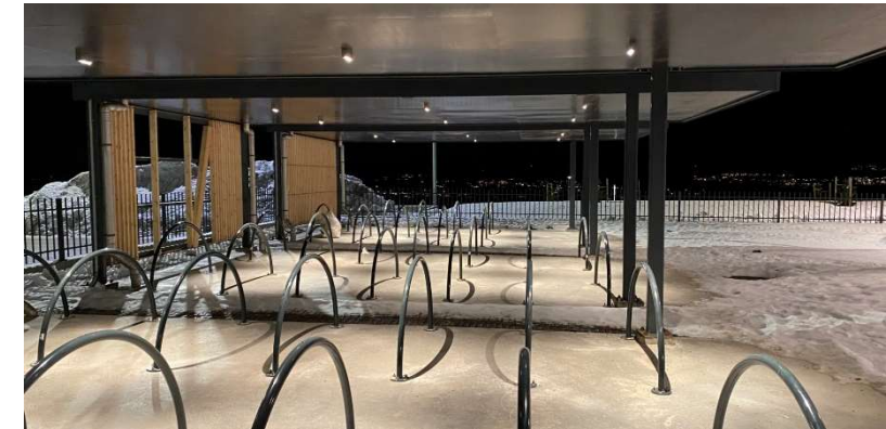
Figur 116 Godt belyste sykkelparkeringer gjør det mer tilgjengelig parkere sykkelen i mørket og det føles tryggere.
