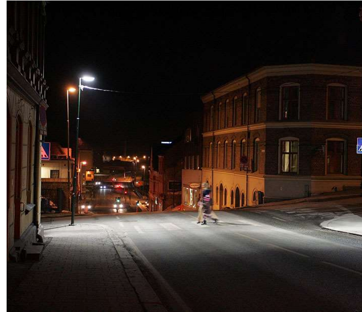
Figur 14 Eksempel på forsterket belysning med en mast som lyser asymmetrisk på hver side av veien
