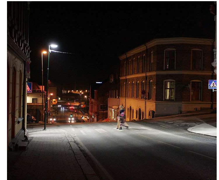
Figur 72 Eksempel på forsterket belysning ved gangfelt
